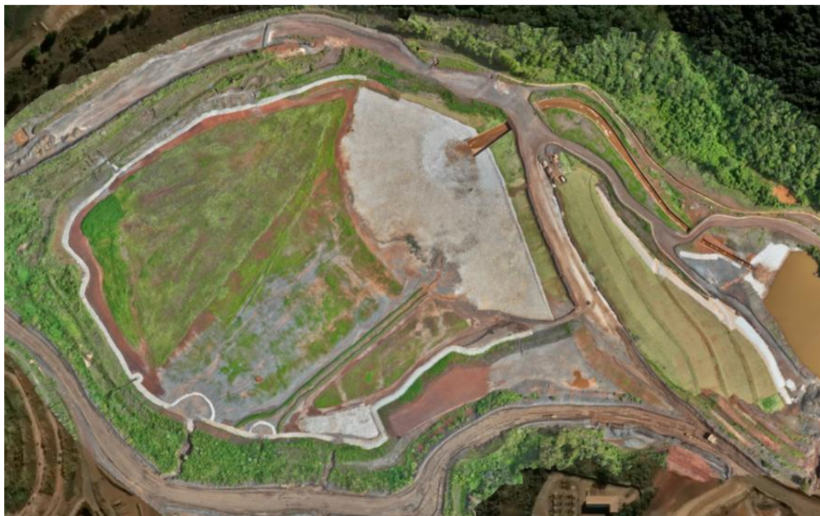
Figura 23 - Aplicação de MVP na região da barragem de Área IX (data: 29/01/2026).
