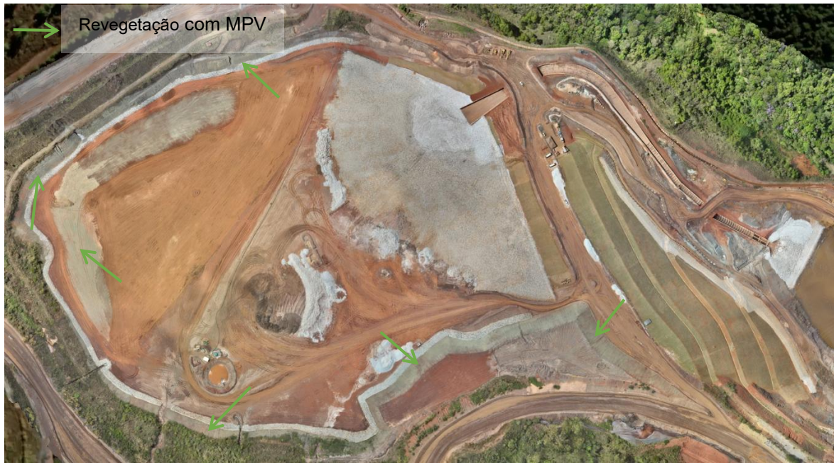
Figura 90 - Aplicação de MVP na região da barragem de Área IX (data: 25/10/2025).
