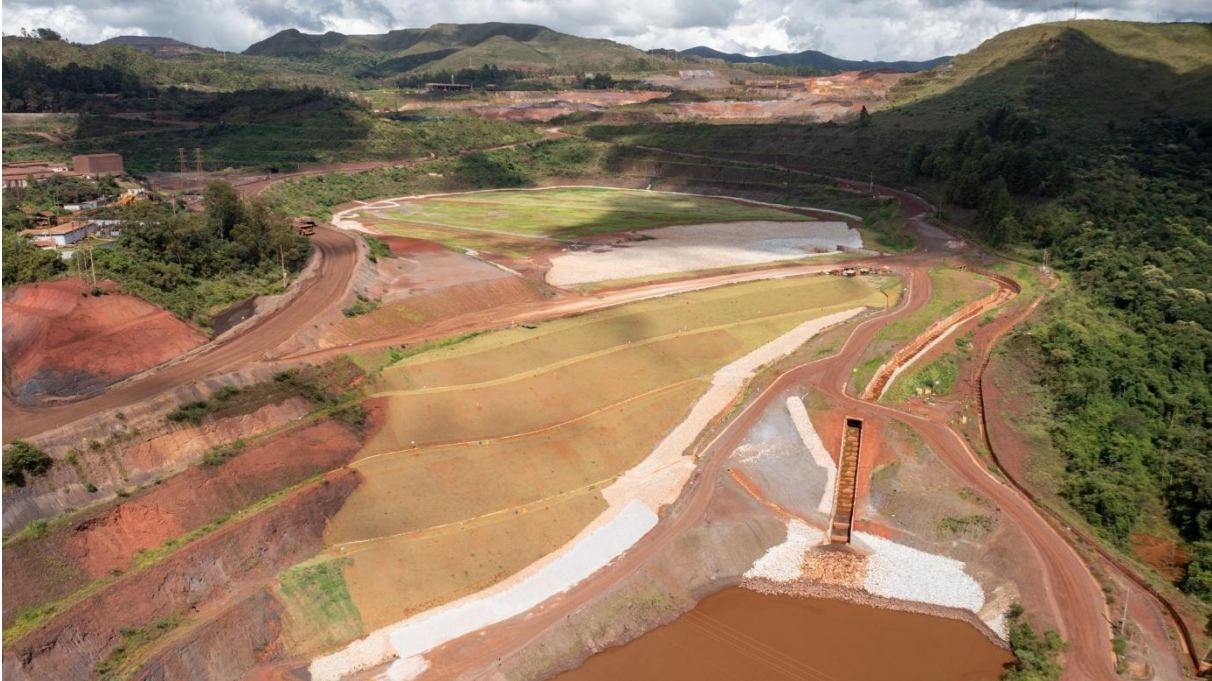
Figura 9 - Visão geral da obra de descaracterização (janeiro/26).
