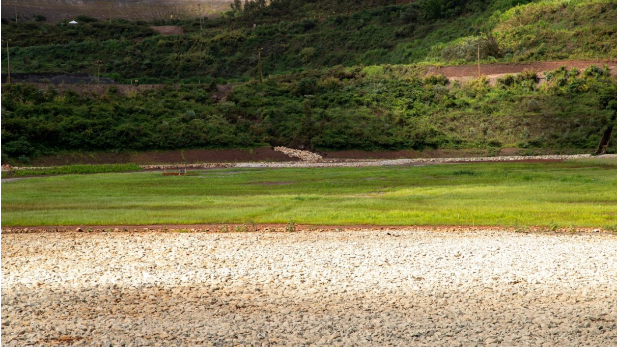
Figura 26: Reservatório da barragem de Área IX (data: 13/01/2026).
