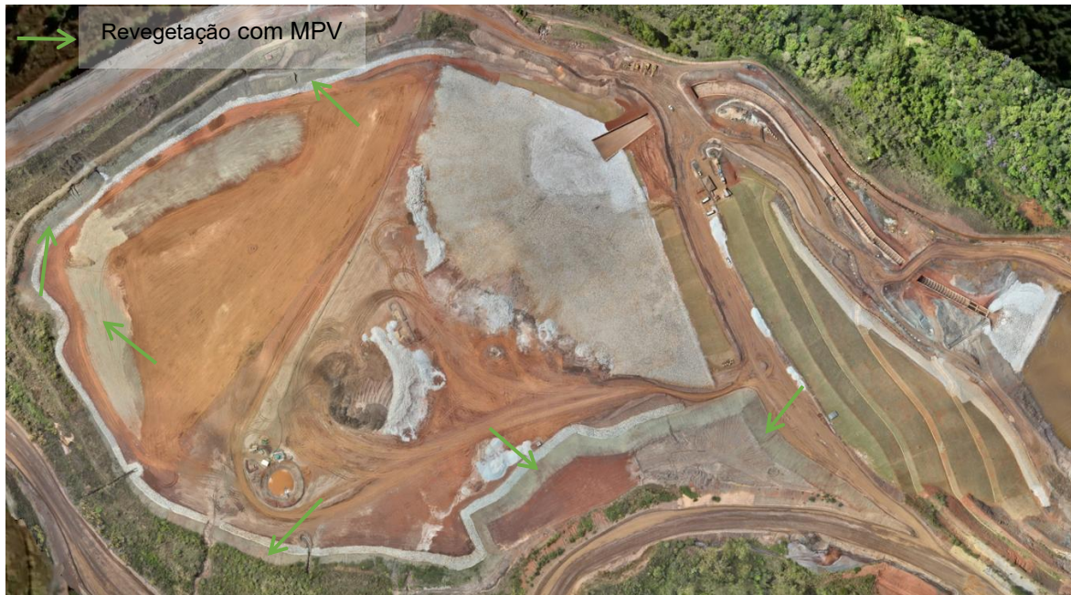
Figura 22 - Aplicação de MVP na região da barragem de Área IX (data: 25/10/2025).
