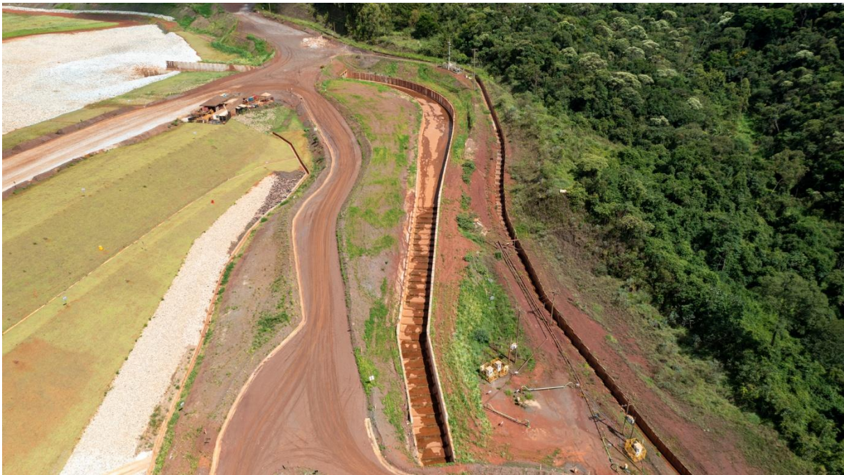
Figura 95: Paredes externas do canal extravasor (data: 13/01/2026).
