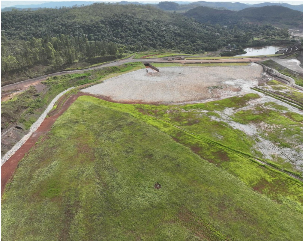
Figura 7 – Vista geral do maciço e reservatório (janeiro/2026).
