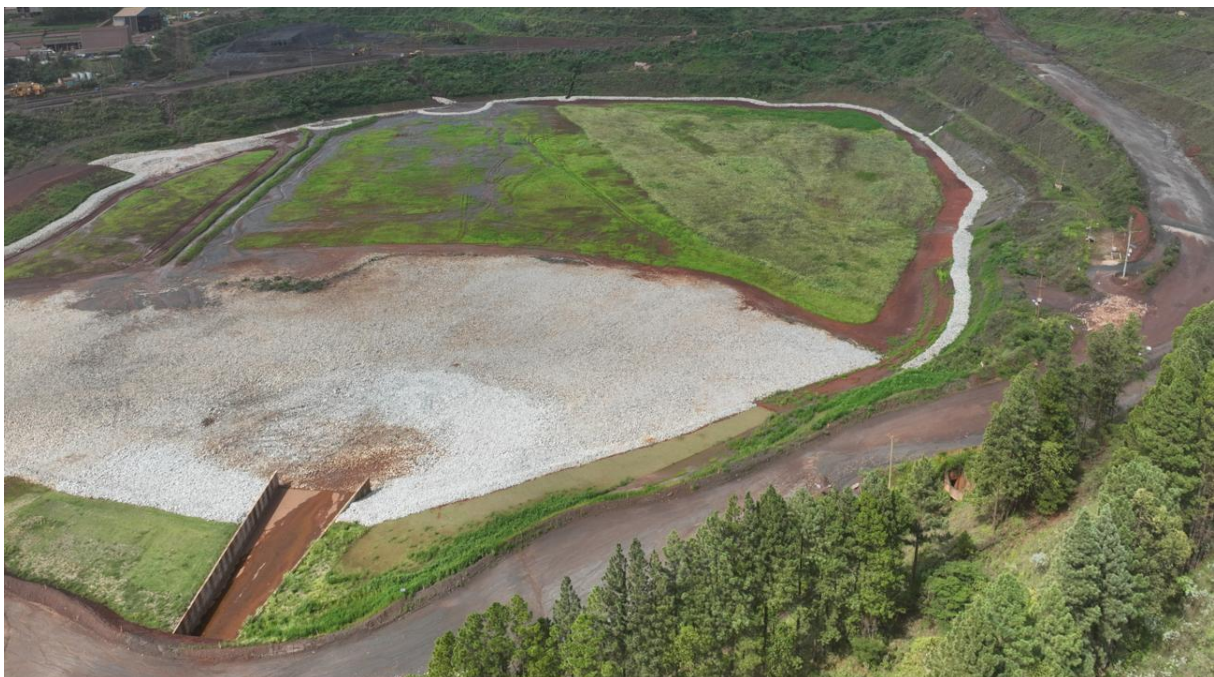
Figura 6 – Acabamento com material argiloso e topsoil para plantio de vegetação (janeiro/2026)
