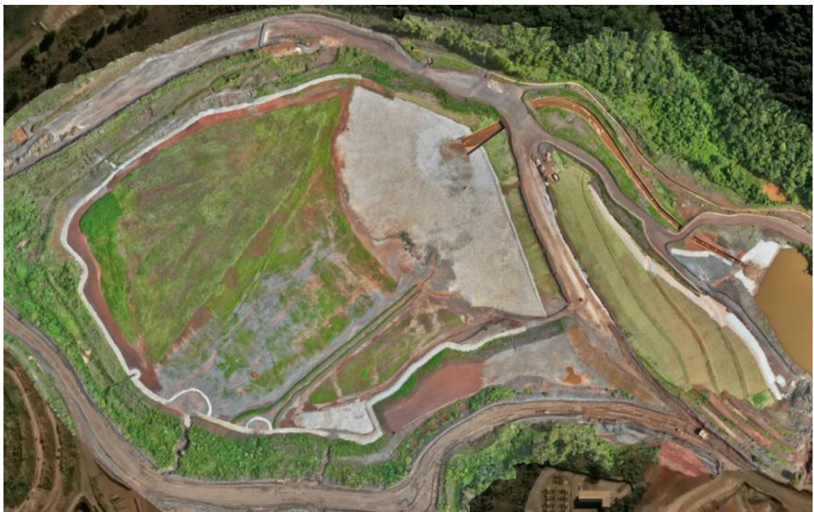
Figura 91 - Aplicação de MVP na região da barragem de Área IX (data: 29/01/2026).
