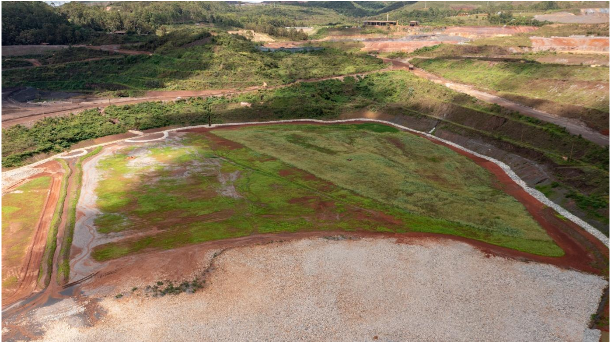
Figura 24: Reservatório da barragem de Área IX (data: 13/01/2026).
