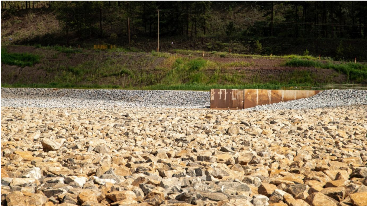
Figura 13 – Emboque canal de drenagem (janeiro/26).
