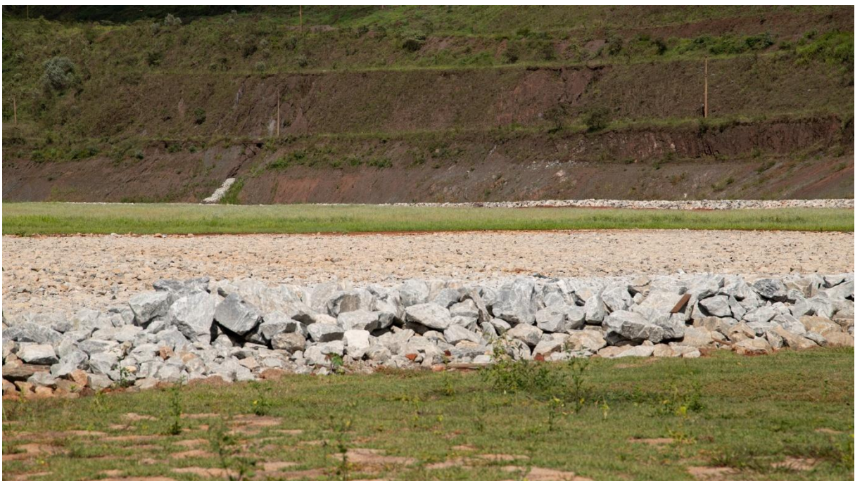
Figura 14 – Emboque canal de drenagem e antigo reservatório revegetado (janeiro/26).
