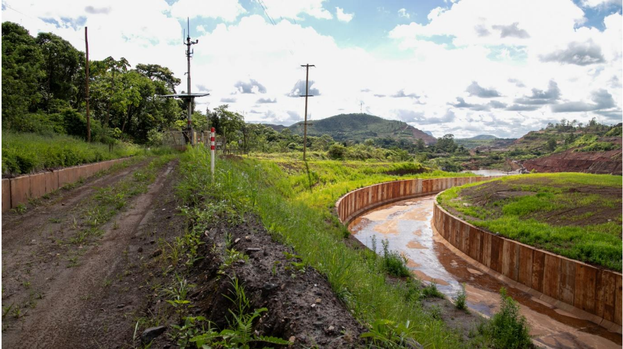
Figura 28: Paredes externas do canal extravasor (13/01/2026).
