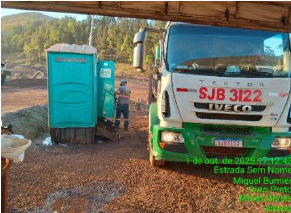
Figura 70 – Higienização dos banheiros químicos disponíveis nas frentes de obra.
