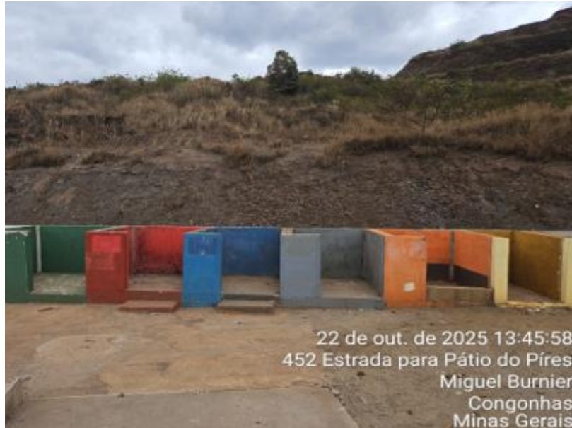
Figura 82 – Processo de desmobilização do DIR do canteiro da Área VIII.
