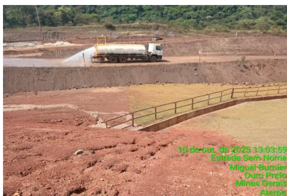
Figura 32 - Caminhão pipa realizando aspersão das vias de acesso.
