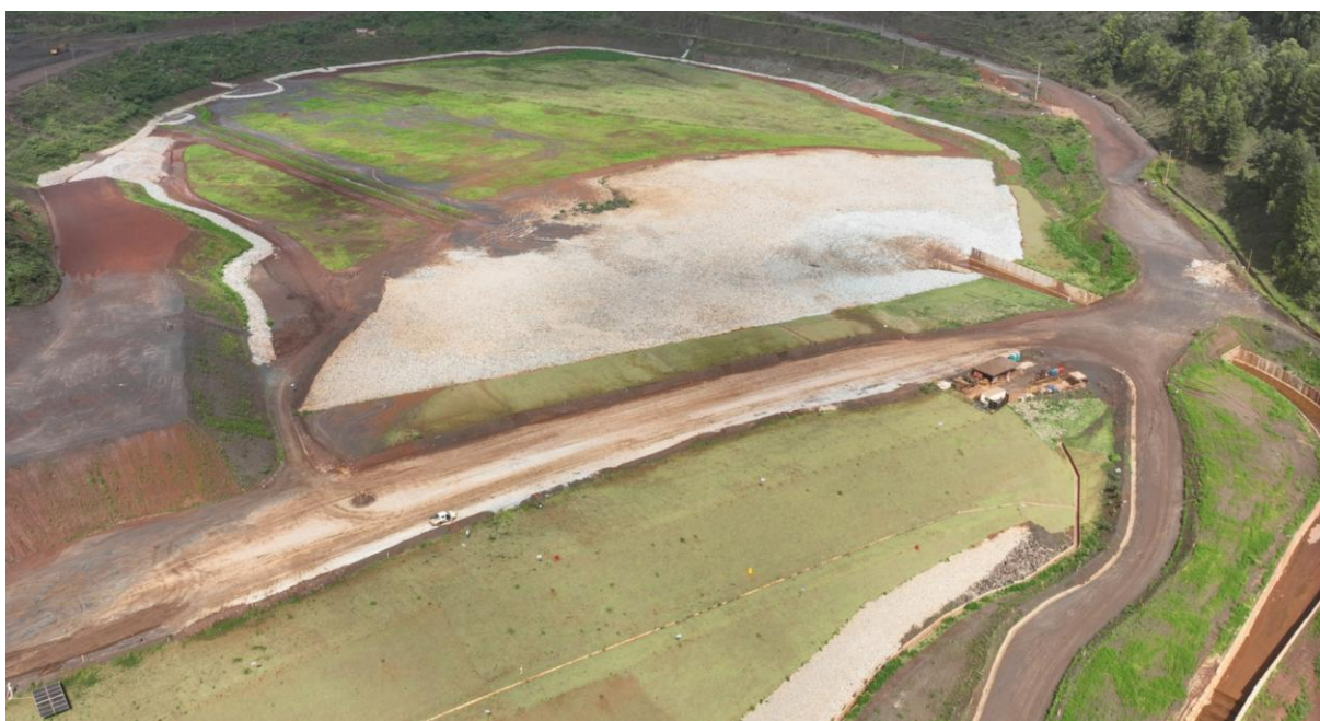
Figura 8 - Visão geral da estrutura (janeiro/26).
