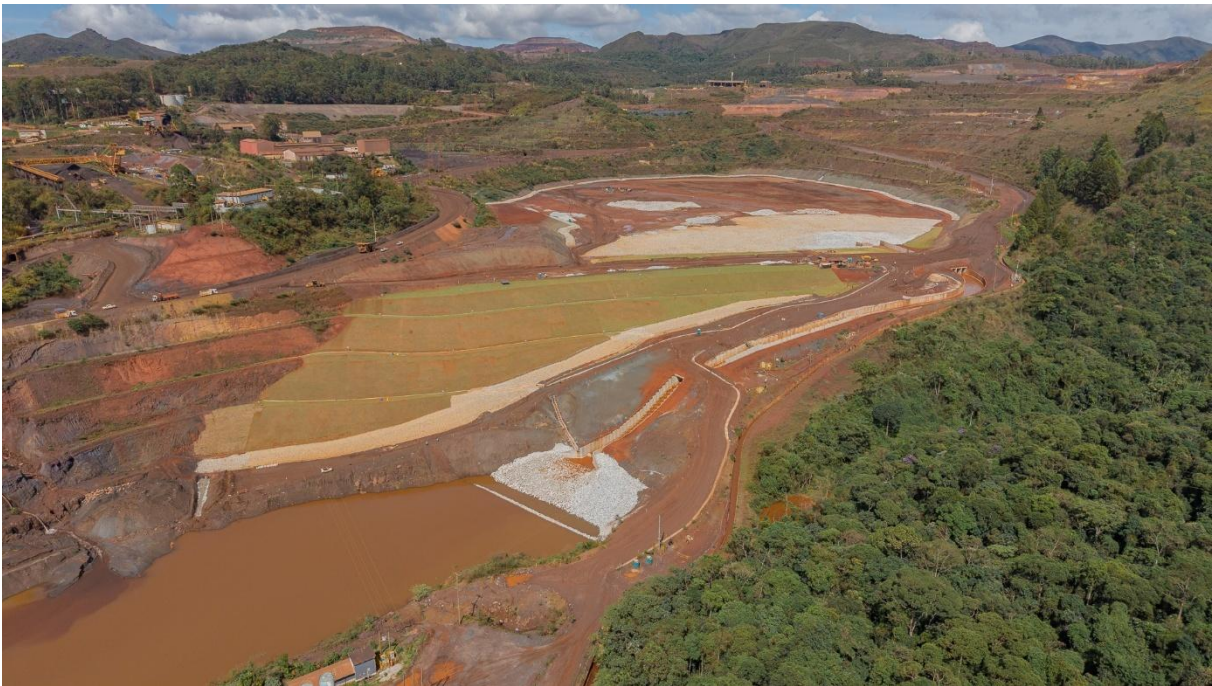
Figura 4 - Plantio de grama no talude jusante do reforço (novembro/25).
