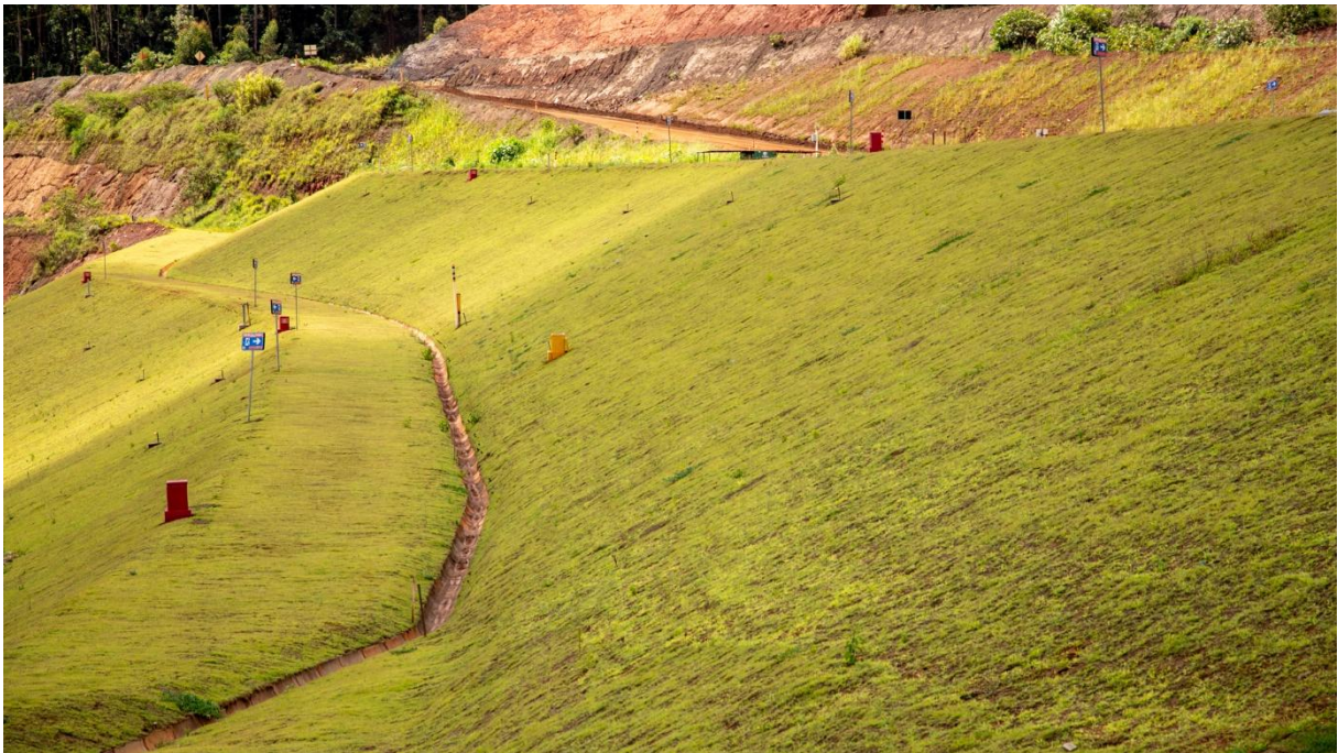
Figura 29: Grama aplicada no reforço da barragem de Área IX (13/01/2026).
