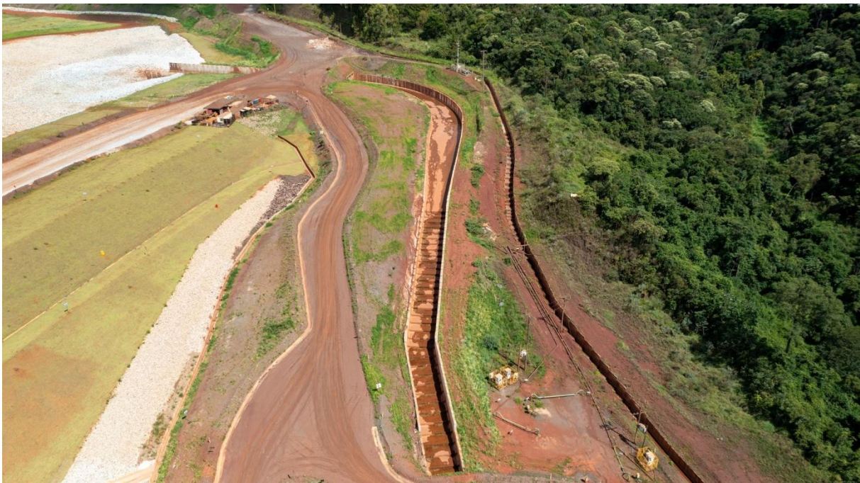
Figura 12 – Canal de drenagem (janeiro/26).
