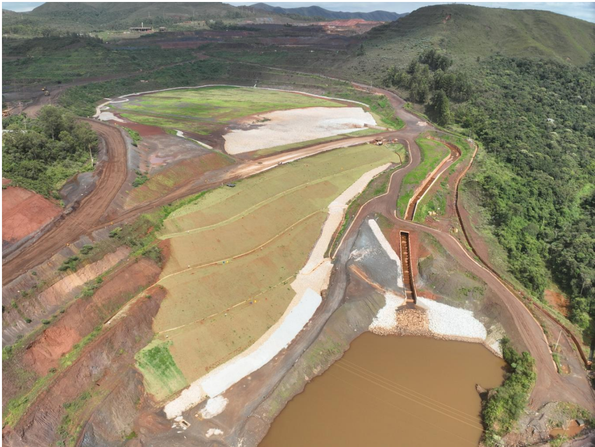
Figura 5 - Remoção dos sumps no reservatório (janeiro/26).
