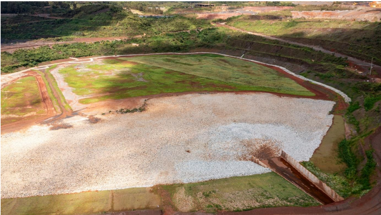
Figura 10 - Visão geral do reservatório (janeiro/26).
