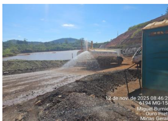
Figura 35 - Aspersão de água nos acessos.
