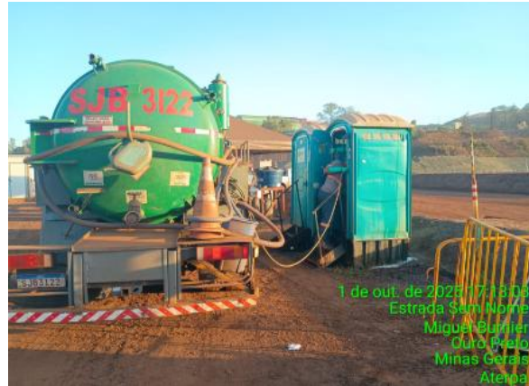
Figura 71 – Sucção dos efluentes e higienização dos banheiros químicos.
