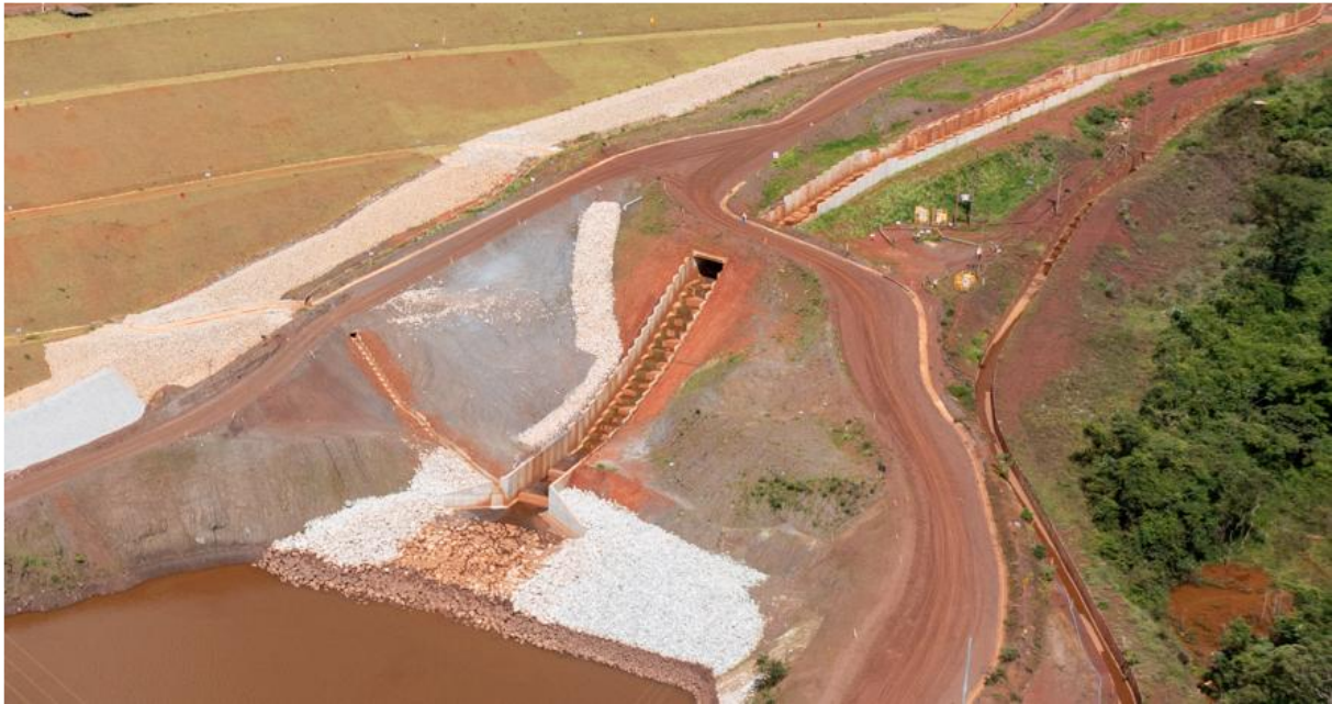
Figura 11 – Bacia de dissipação/proteção em enrocamento - canal de drenagem (janeiro/26).
