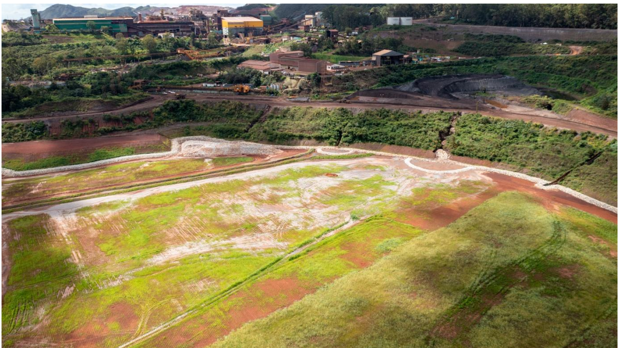
Figura 25: Reservatório da barragem de Área IX (data: 13/01/2026).
