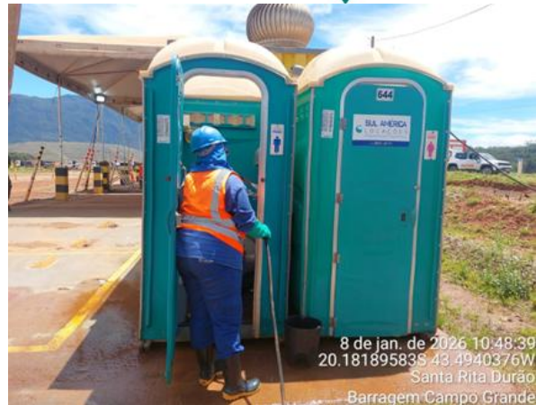
Figura 50 – Limpeza de banheiro químico.
