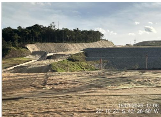
Figura 27 – Aplicação de biomanta no Maciço Principal. Fonte: Vale, 2026.
