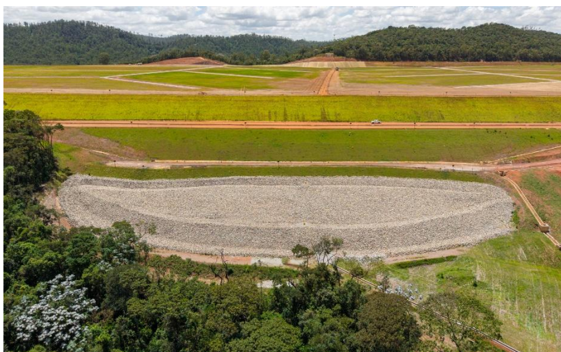
Figura 15 - Obras no Dique de Sela: estrutura concluída, com drenagens superficiais finalizadas (Jan/2026).
