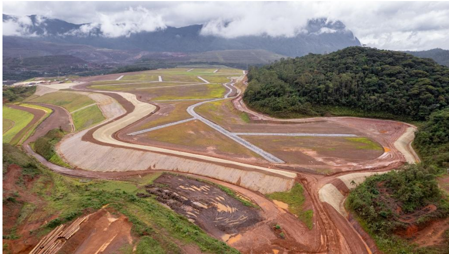
Figura 16 - Obras no Regreide – Conclusão do Regreide (Jan/2026).
