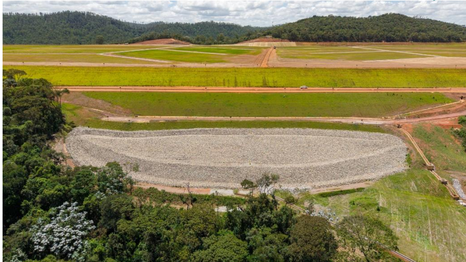
Figura 6 - Estrutura Dique de Sela – Janeiro/2026.
