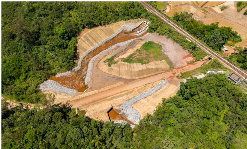
Figura 17 – Conclusão da TP-08 e Canal de Restituição (Jan/2026).
