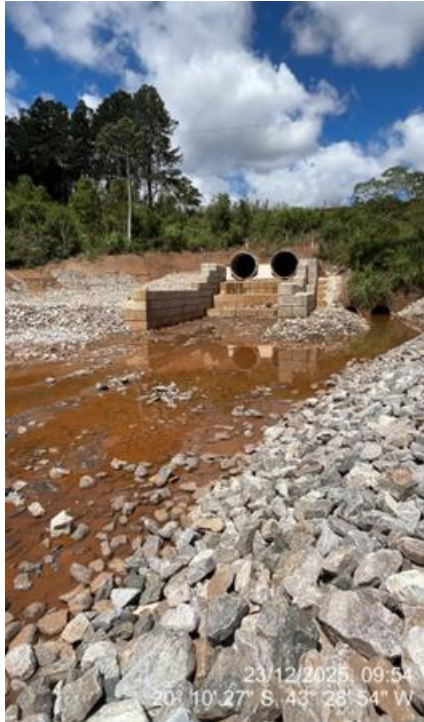
Figura 21 – Desemboque do túnel liner.
