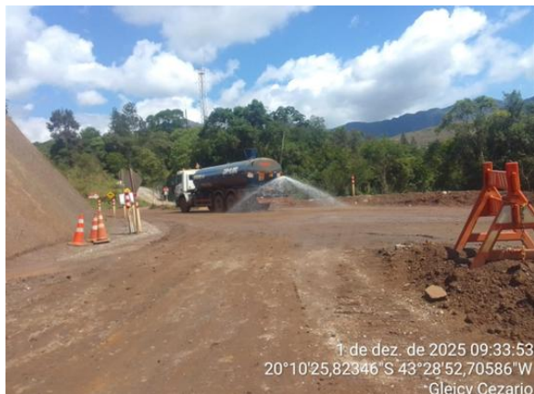
Figura 40 - Umectação de vias na entrada principal da obra.
