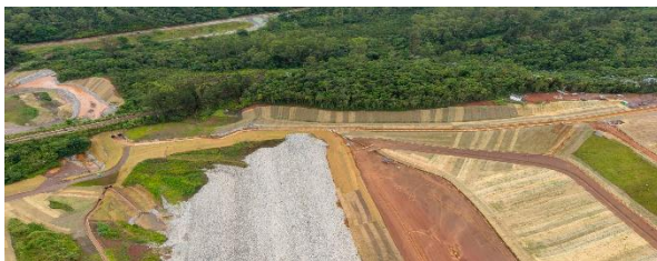
Figura 23 – Reconformação de talude às margens do canal lateral para receber hidrossemeadura e biomanta.
