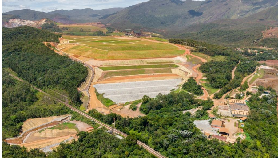
Figura 9 – Estrutura Maciço Principal – Janeiro/26.
