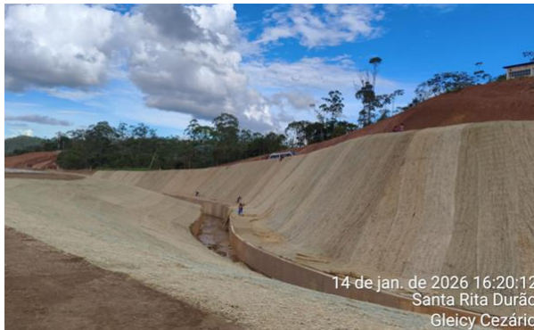
Aplicação de biomanta de capim nos taludes do canal lateral. Fonte: Vale, 2026
