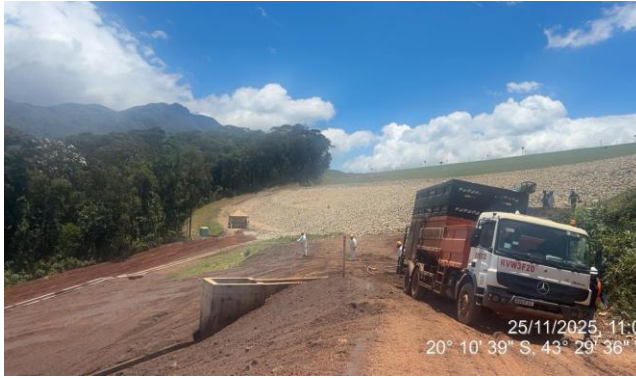
Figura 25 – Aplicação de hidrosseadura no Dique de Sela. Fonte: Vale, 2025.
