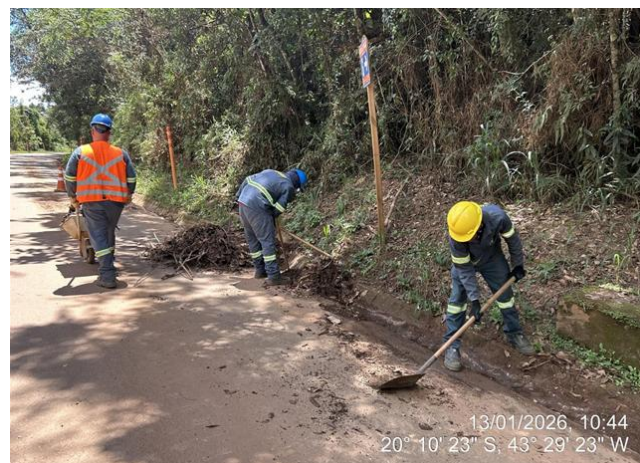
Figura 20 – Limpeza de canaleta no acesso principal.
