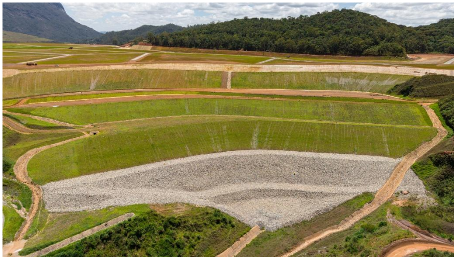
Figura 7 - Estrutura Dique Norte Sul – Janeiro/2026.
