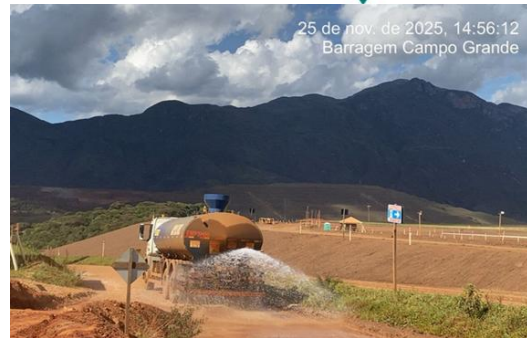
Figura 39 - Umectação de vias no acesso intermediário, canteiro de obras e regreide.
