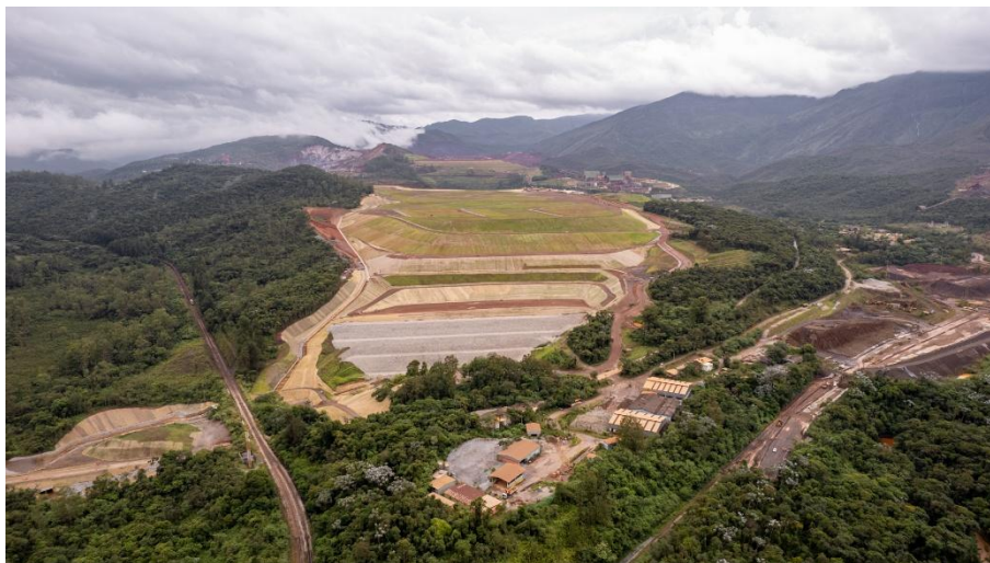
Figura 14 - Obras no Maciço Principal: estrutura concluída, com drenagens e revegetação finalizados (Jan/2026).
