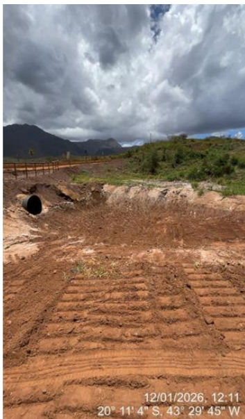
Figura 19 – Desassoreamento do sump Dique Norte-Sul.
