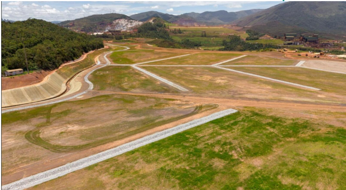
Figura 12 – Antiga região do reservatório e bombeamento da Estrutura Remanescente Campo Grande, regreide finalizado.
