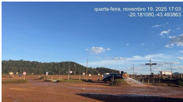
Figura 38 - Umectação de vias próximo à antiga portaria 2.
