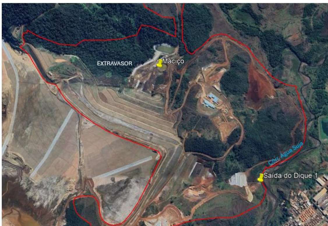
Figura 54 - Localização dos pontos de monitoramento diário de efluentes, para o parâmetro turbidez, no maciço principal e dique 1.
