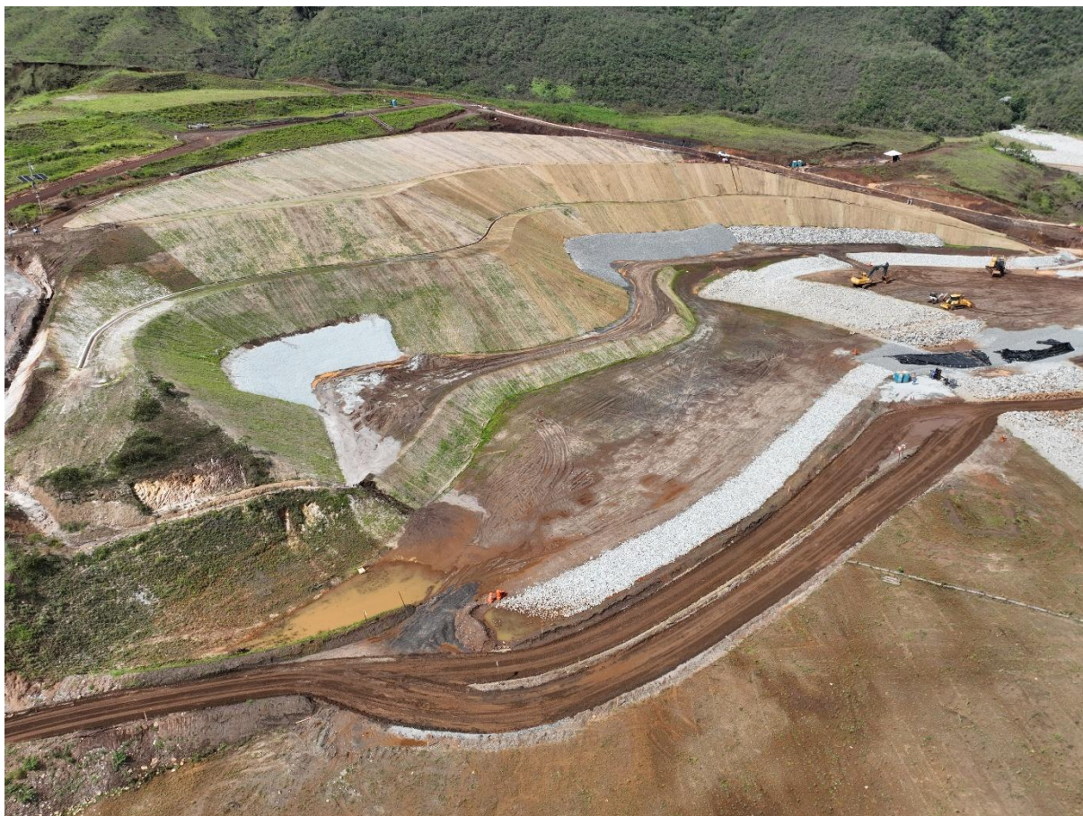
Figura 13 – Talude 08, vista para a face do talude escavada concluída e revegetada e dispositivos de drenagem superficial com execução em andamento – foto dia 08/01/2026
