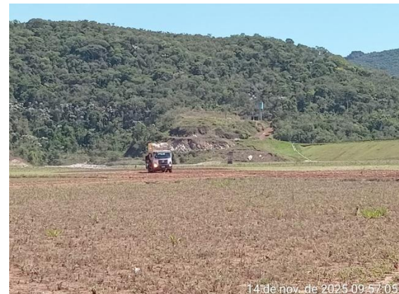
Figura 30 – Aplicação de manta vegetal projetada no regreide. Fonte: Vale, 2026.
