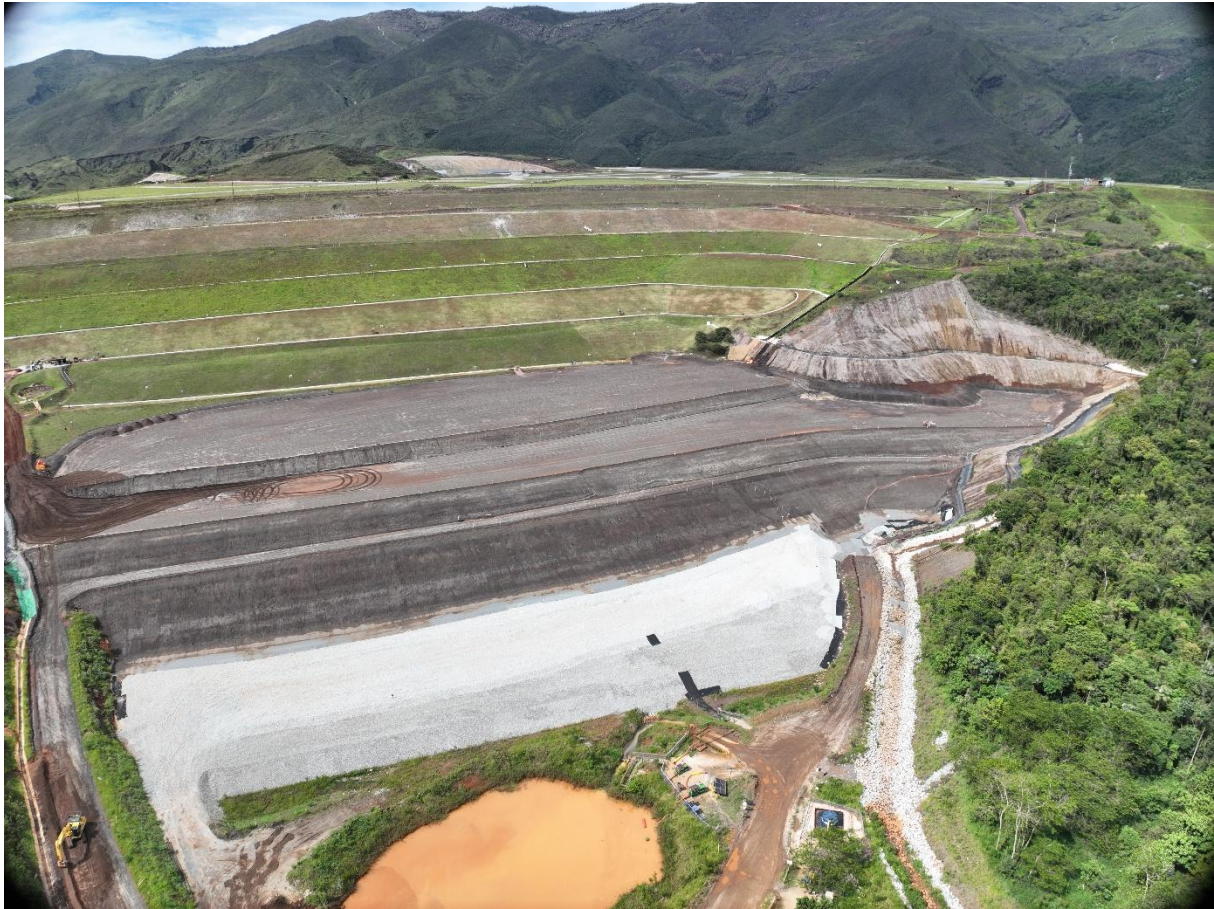
Figura 12 – Maciço Principal, vista para o tratamento de fundação e saída de drenagem, aterro de reforço em andamento e dispositivos de drenagem temporários previstos no plano de chuvas 2025/2026 – foto dia 08/01/2026
