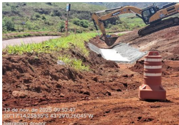
Figura 24 - Concretagem da canaleta do pátio 6.
