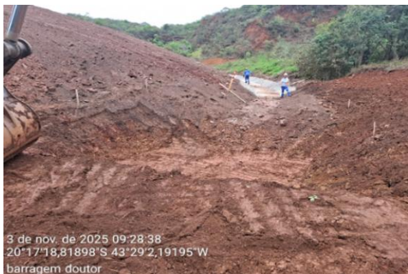
Figura 23 - Escavação para construção do sump no pátio 6. Vale, 2026.
