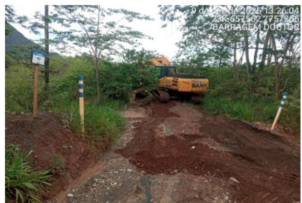
Figura 22 - Limpeza canaletas semimecanizada do pátio 06. Fonte: Vale, 2026.
