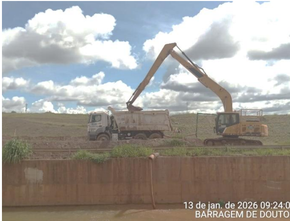
Figura 17 - Limpeza da bacia do extravasor. Fonte: Vale, 2026.
