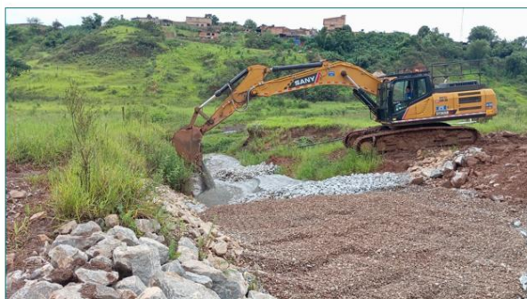
Manutenção de filtro
