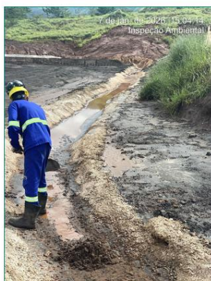
Limpeza de canaletas
