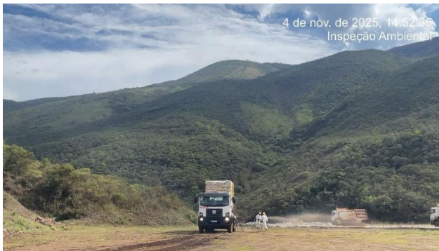
Figura 29 – Aplicação de manta vegetal projetada no regreide. Fonte: Vale, 2026.
