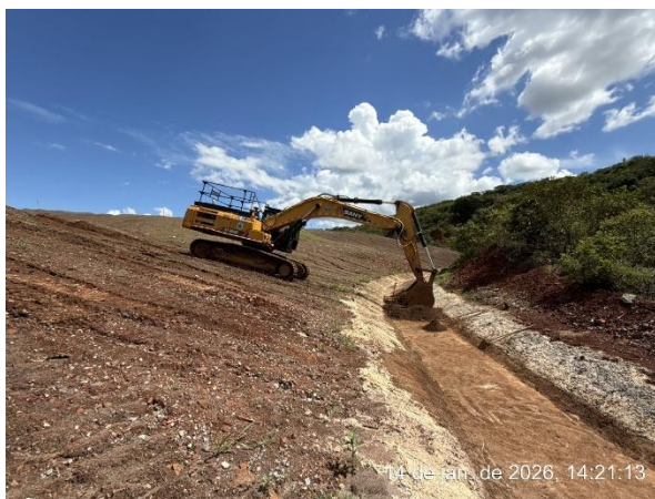
Figura 15 - Limpeza canaletas semimecanizada do pátio 06. Fonte: Vale, 2026.
