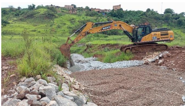
Figura 21 - Adequação do filtro do dique 1. Fonte: Vale, 2026.
