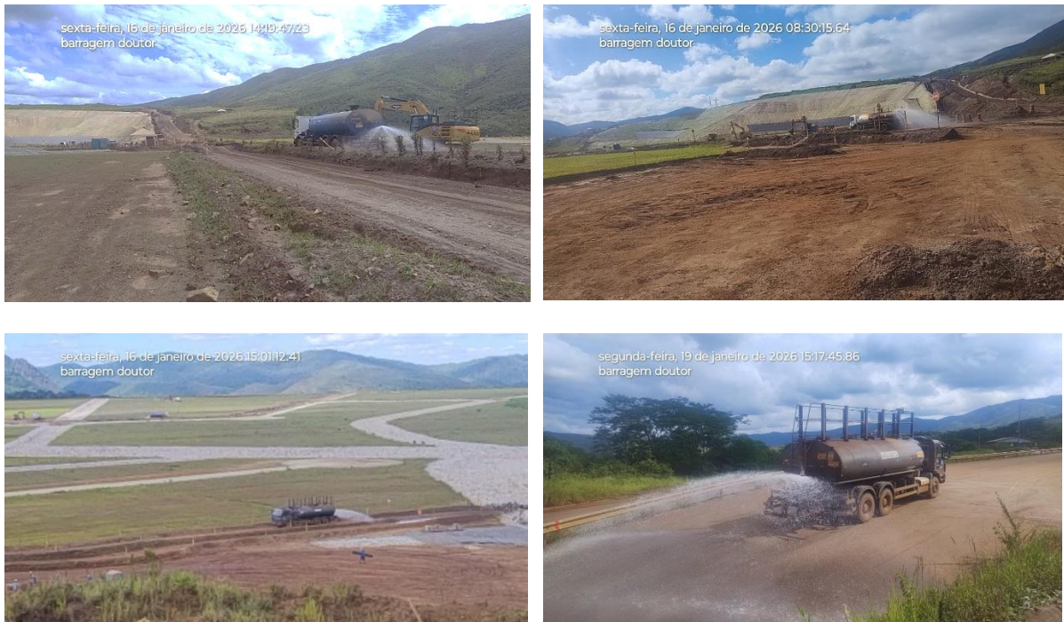
Figura 37 – Atuação do caminhão pipa. Fonte: Vale, 2026.
