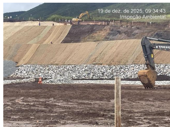
Figura 26 – Revegetação com MVP e biomanta no talude 8 - atividade de aplicação de biomanta.
