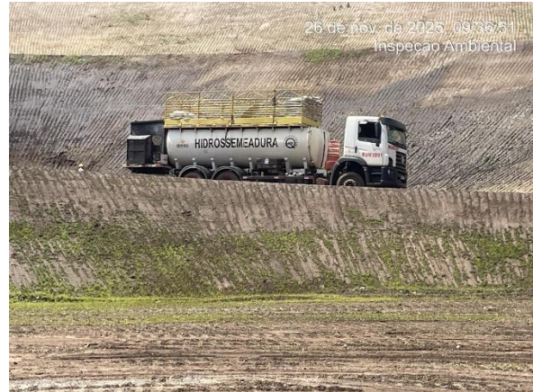
Figura 28 - Aplicação de manta vegetal projetada no talude 8. Fonte: Vale, 2026.
