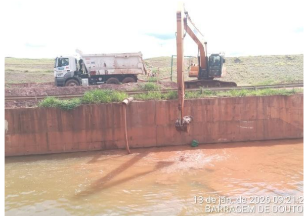
Figura 18 - Limpeza da bacia do extravasor. Fonte: Vale, 2026.
