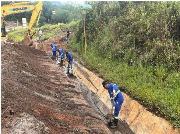
Figura 19 - Limpeza de canaletas do maciço principal. Fonte: Vale, 2026.
