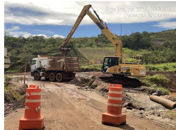
Figura 20 - Limpeza do 1º sump do maciço principal. Fonte: Vale, 2026.
