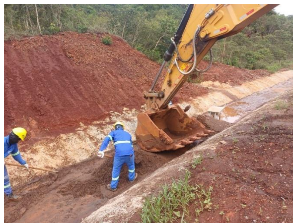
Figura 16 - Limpeza canaletas semimecanizada do pátio 06. Fonte: Vale, 2026.
