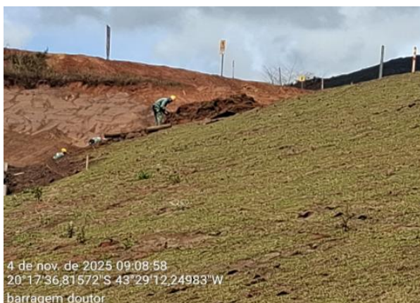
Figura 25 – Plantio de grama no dique 1 realizado.
