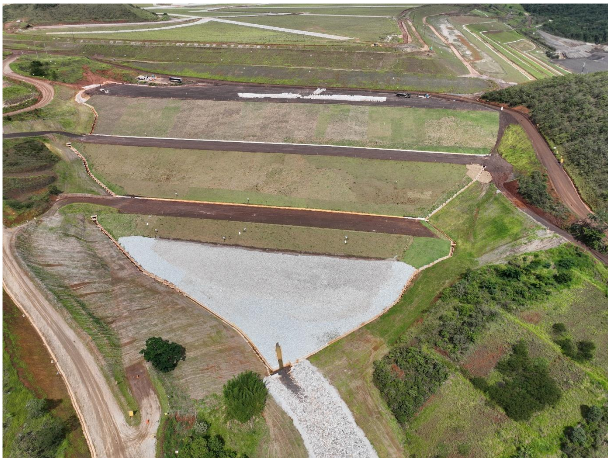
Figura 9 - Dique 1 (Imagem de 08/01/2026).
