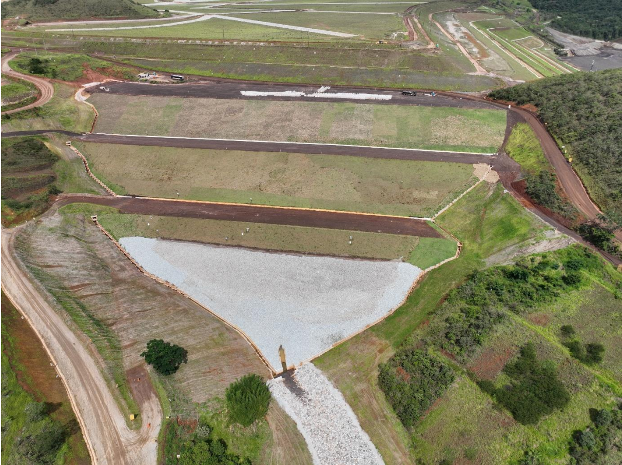
Figura 11 - Vista geral do Dique 1, com saída da drenagem interna do reforço concluída, construída sobre tratamento de função igualmente concluído, vista da face do reforço concluída e revegetada e os trechos dos dispositivos de drenagem superficial executados – foto dia 08/01/2026.
