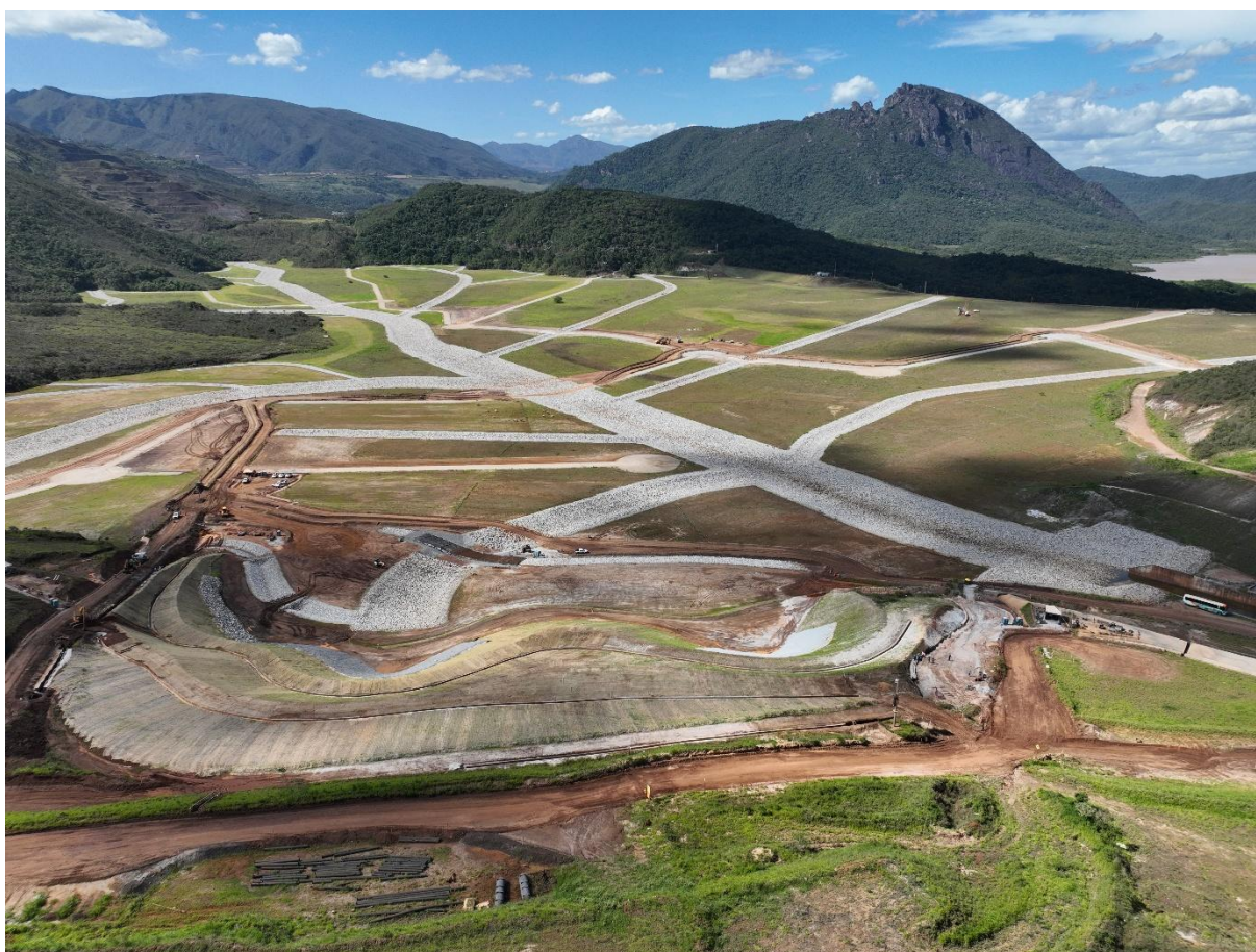
Figura 3 - Vista do Reservatório – Janeiro/2026
