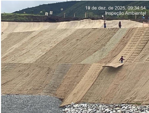
Figura 27 – Revegetação com MVP e biomanta no talude 8. Fonte: Vale, 2026.
