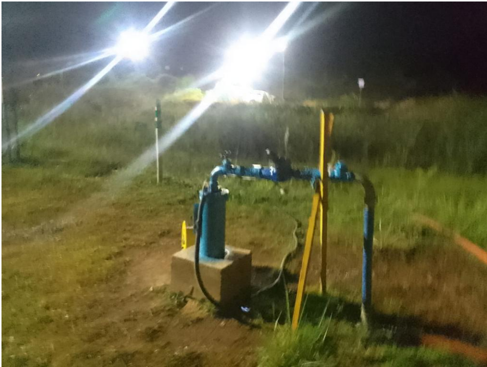
Figura 15 - Teste de bombeamento - Forquilha I
