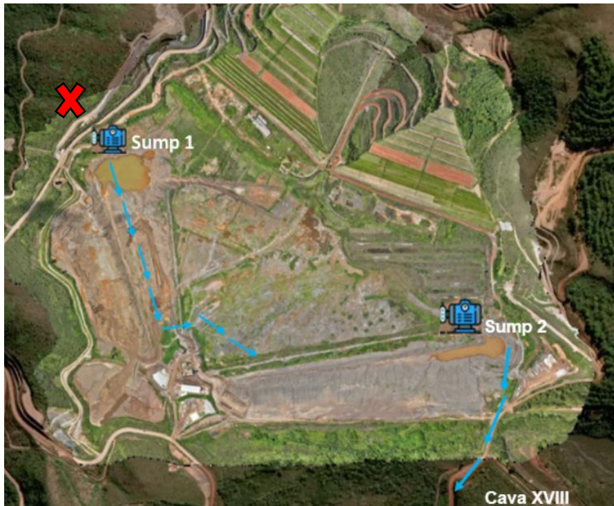
Figura 102 - Bombeamento realizado em Forquilha I e II. Vale, 2025.
