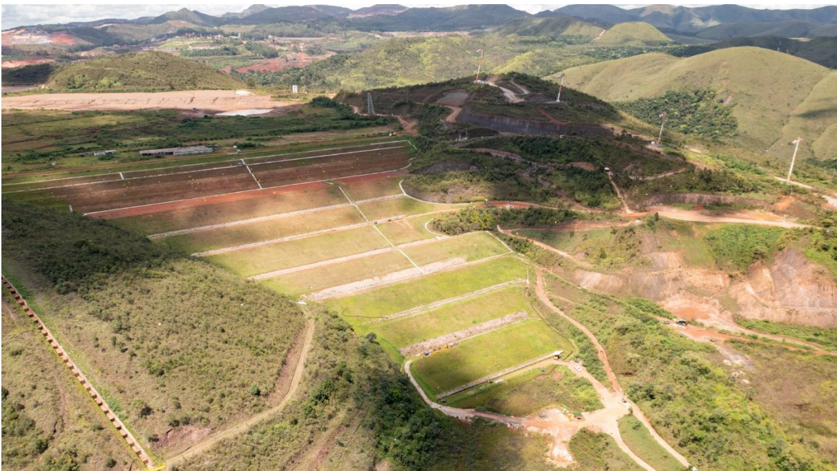
Figura 17 - Visão geral das infraestruturas a serem removidas Forquilha I (janeiro/26).
