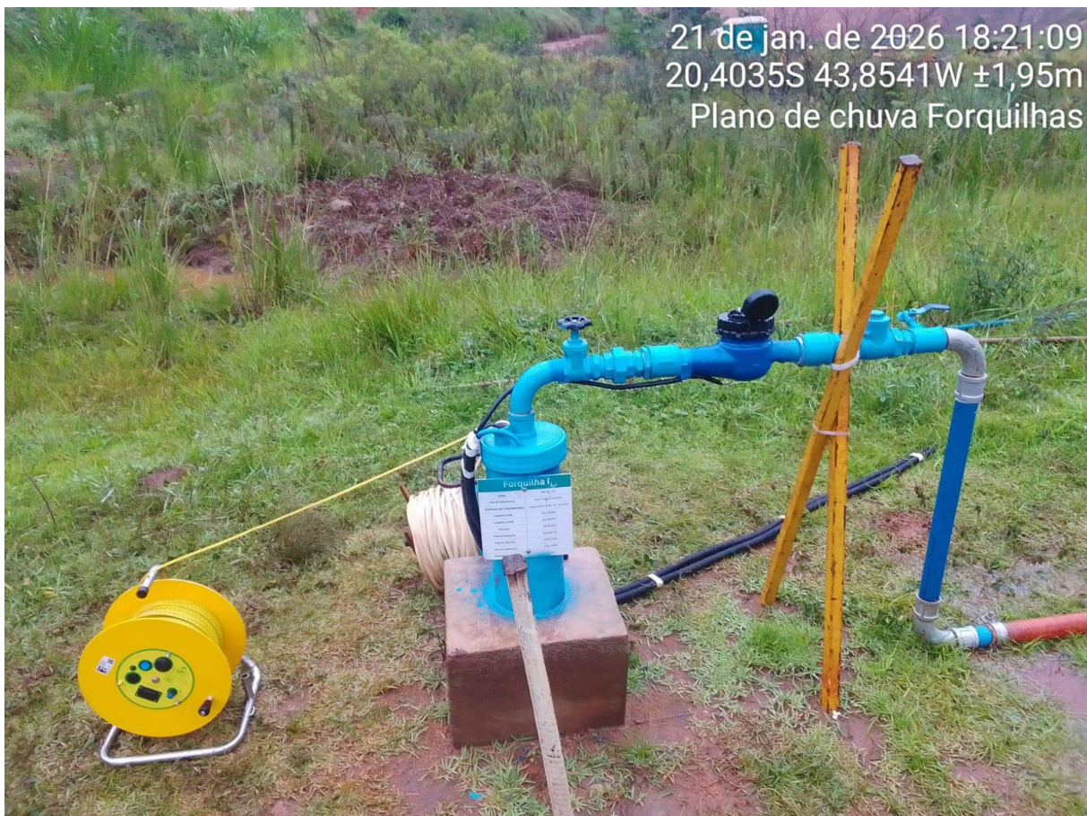
Figura 14 - Teste de bombeamento - Forquilha I
