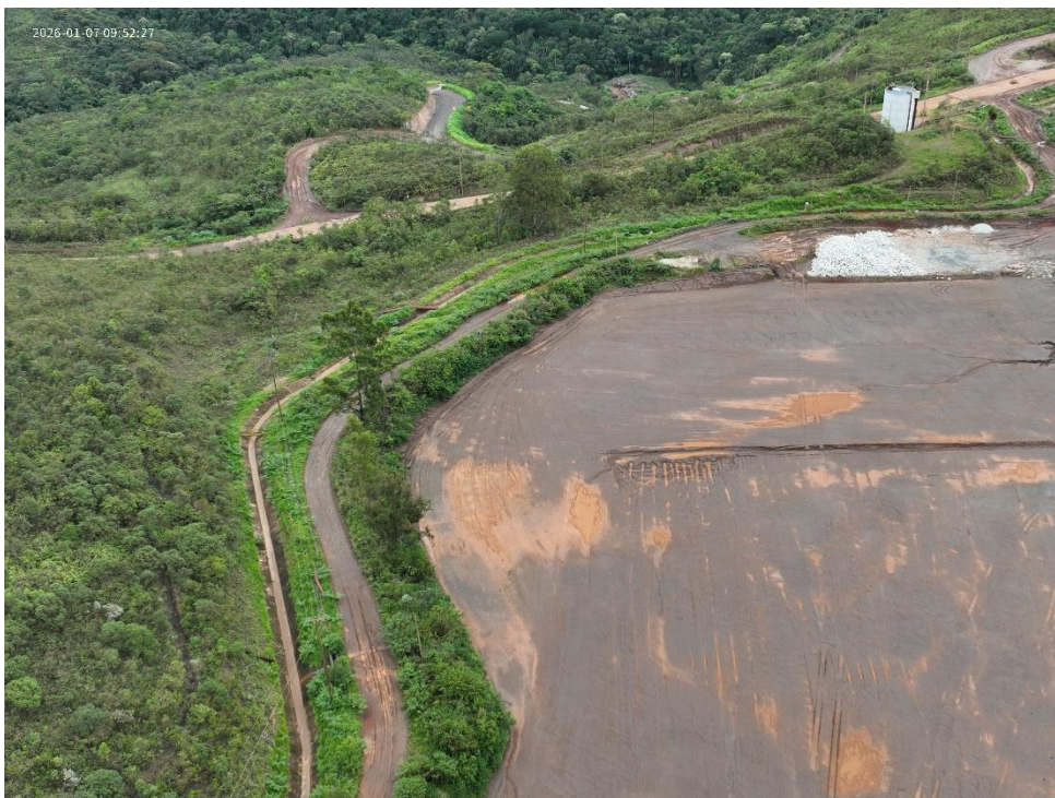
Figura 25 - Inspeção geral canais de cintura Forquilha I (janeiro/26)
