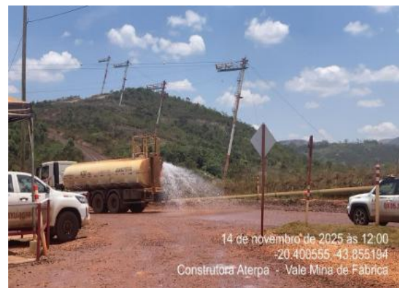
Figura 44 - Aspersão de água nos acessos de obra. Fonte: Vale, novembro de 2025.
