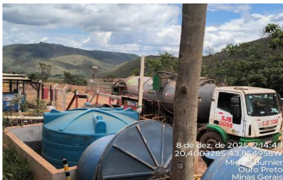
Figura 87 - Sucção de efluentes sanitários armazenados nos tanques sépticos. Fonte: Vale, dezembro de 2025.
