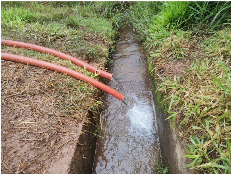
Figura 16 - Teste de bombeamento - Forquilha I
