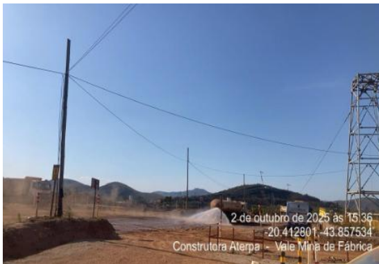
Figura 41 - Atividade de aspersão de água nos acessos de Forquilhas. Fonte: Vale, outubro de 2025.
