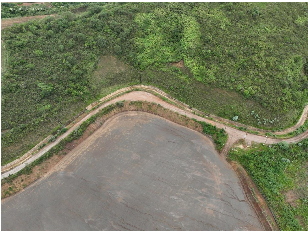
Figura 27 - Inspeção geral canais de cintura Forquilha I (janeiro/26)
