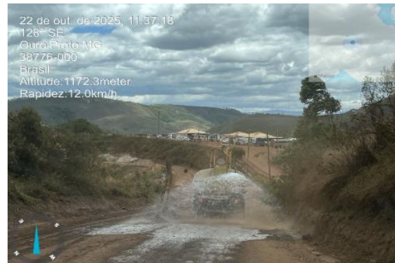
Figura 42 - Aspersão de água nas vias. Fonte: Vale, outubro de 2025.
