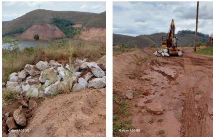
Figura 6 - Atendimento recomendação F1-0364, canteiro administrativo Forquilha I
