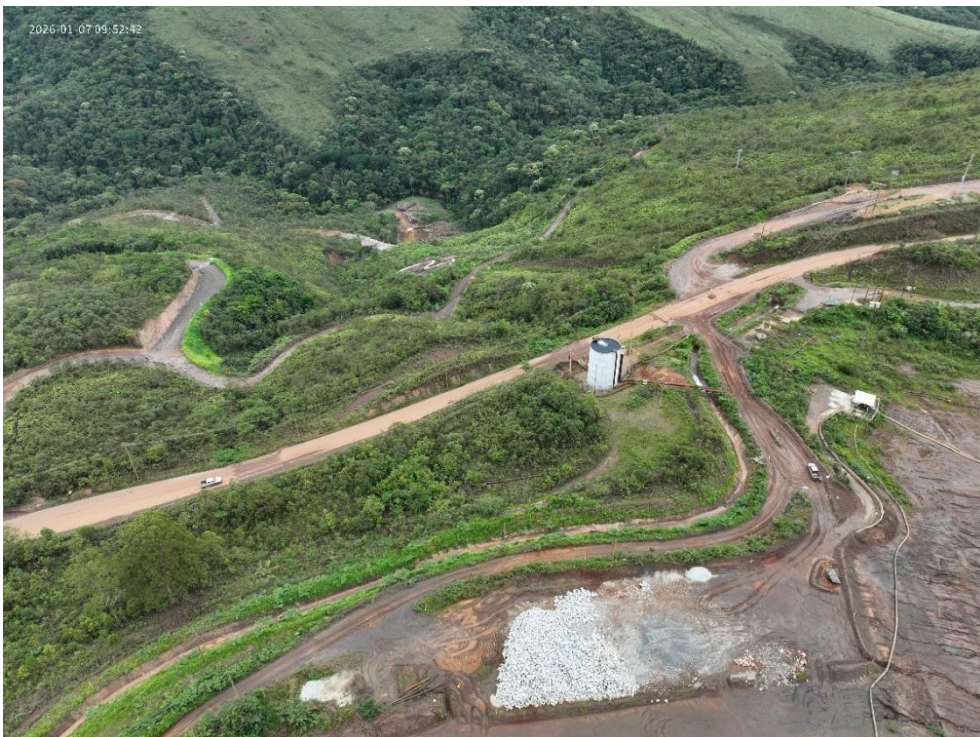
Figura 29 - Inspeção geral canais de cintura Forquilha I (janeiro/26)
