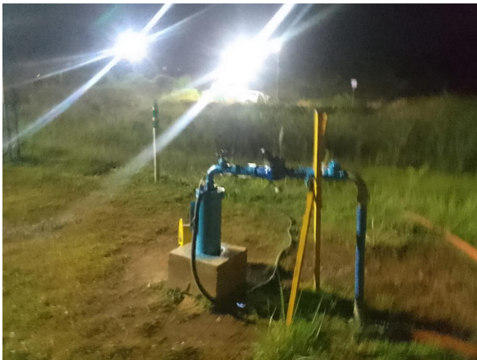
Figura 19 - Teste de bombeamento Forquilha I (janeiro/26)
