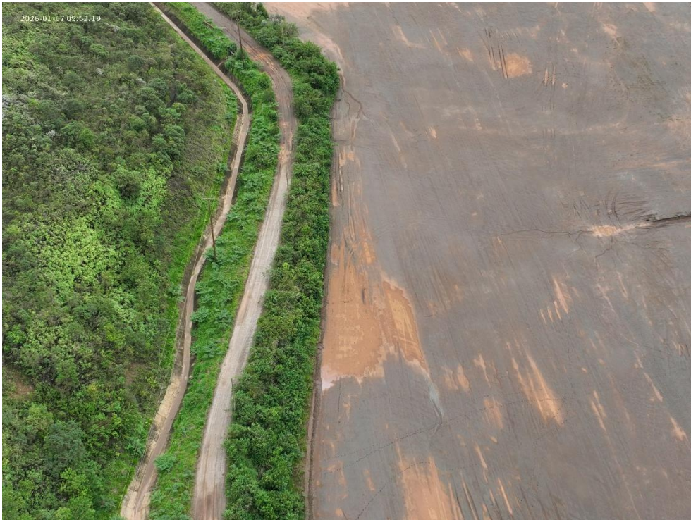
Figura 26 - Inspeção geral canais de cintura Forquilha I (janeiro/26)
