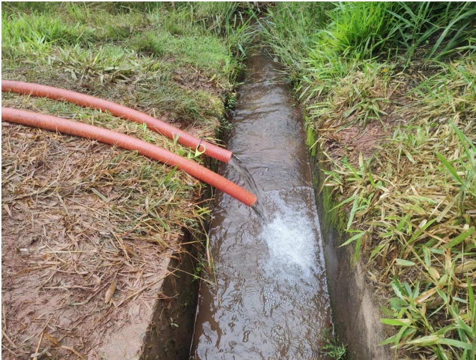
Figura 20 - Teste de bombeamento Forquilha I (janeiro/26)
