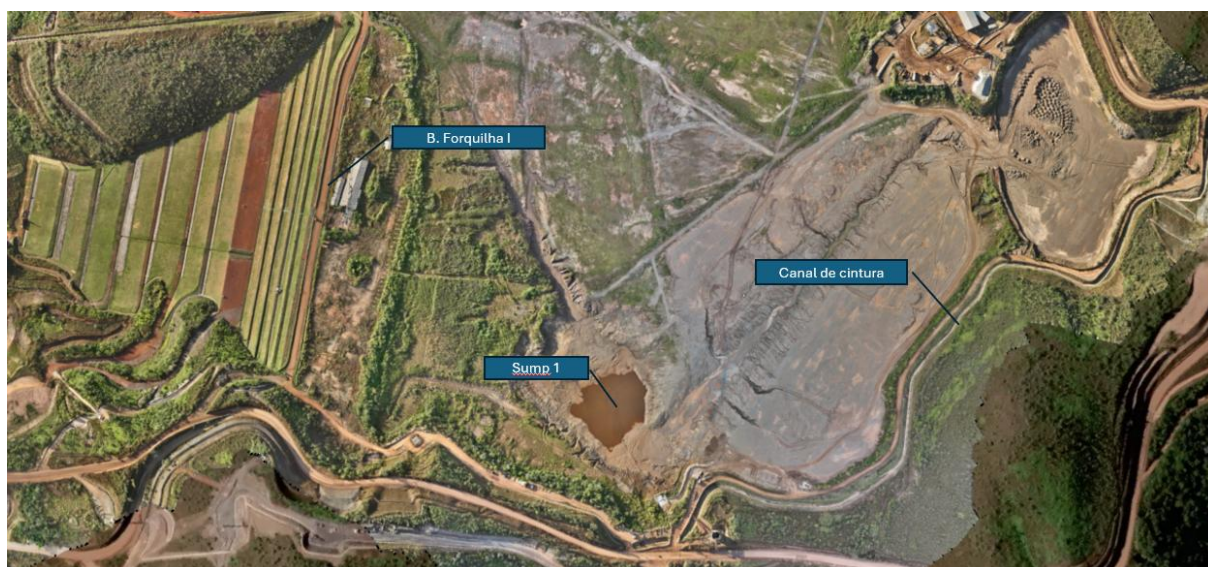
Figura 13 - Canal de cintura implantado em 2020
