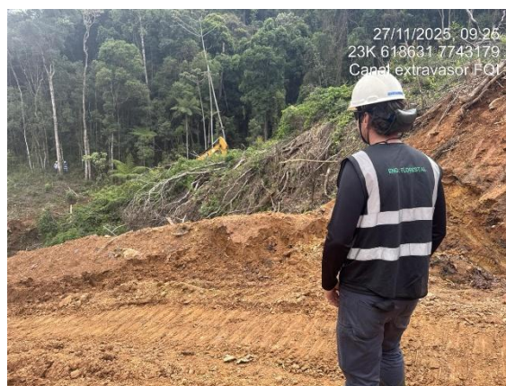
Figura 38 - Acompanhamento da equipe ambiental das atividades de remoção de topsoil na Ombreira esquerda da barragem Forquilha I- Mina de Fábrica. Fonte: Concremat, 2025.
