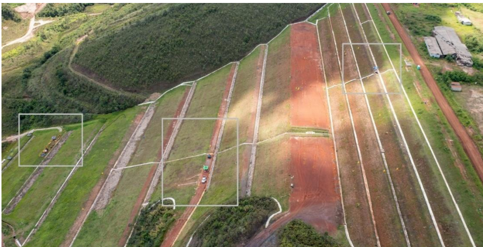
Figura 21 - Investigações geológico geotécnicas em Forquilha I (janeiro/26)
