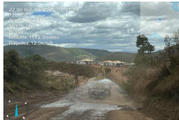
Figura 35 - Aspersão de água nas vias. Fonte: Vale, outubro de 2025.
