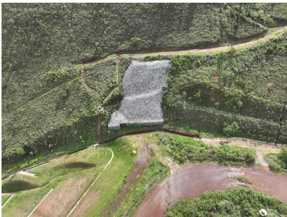
Figura 19 - Status da limpeza e estado de conservação dos canais de cintura – Forquilha II (janeiro/26).
