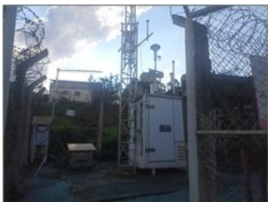
Figura 48 - Estação de Monitoramento de Qualidade do Ar Pires.
