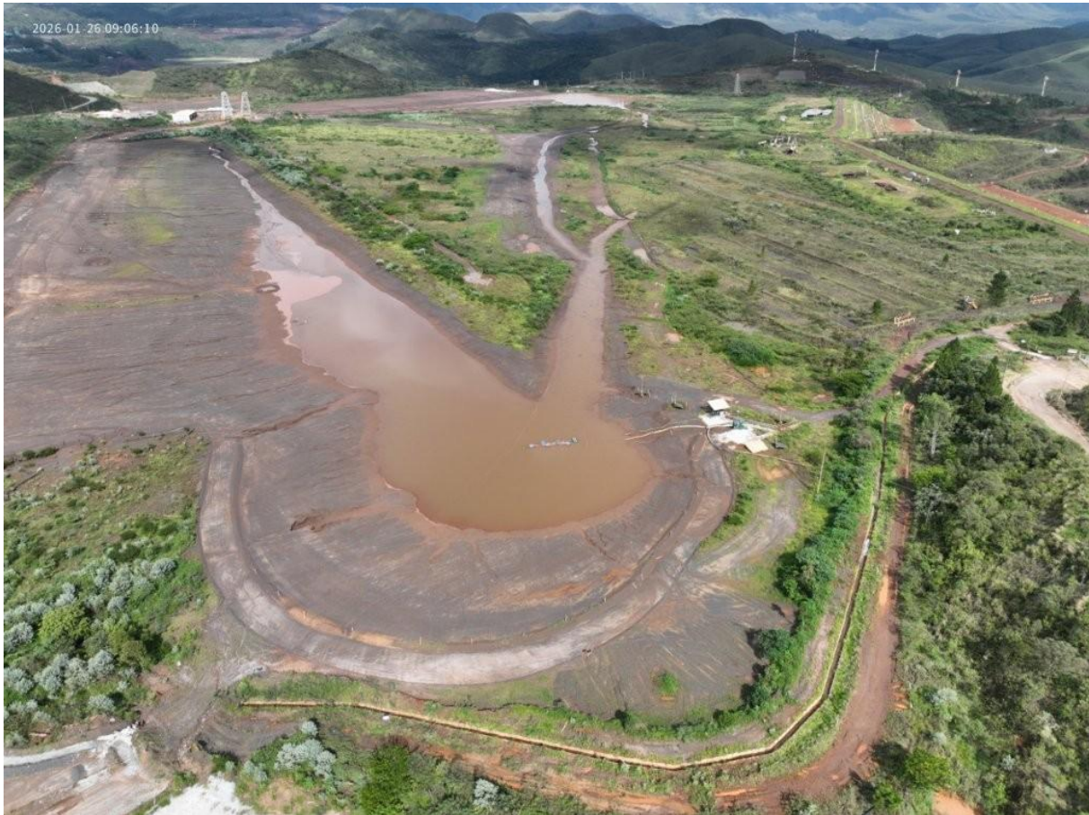
Figura 20 – Estado de conservação dos canais de cintura – Forquilha II (janeiro/26).
