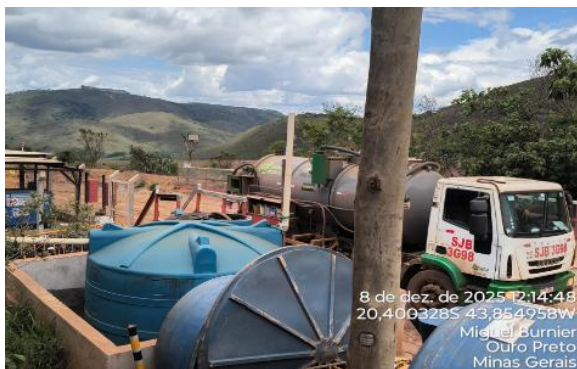
Figura 80 - Sucção de efluentes sanitários armazenados nos tanques sépticos.
