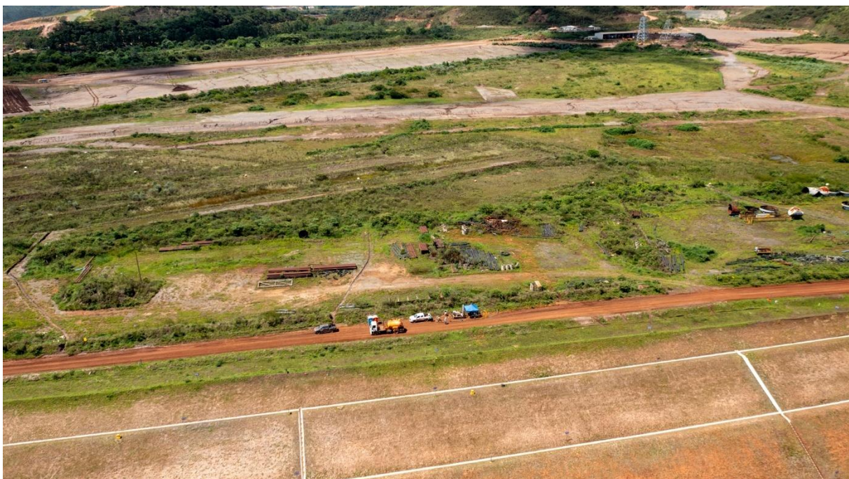
Figura 14 - Visão geral das infraestruturas a serem removidas Forquilha II (janeiro/26)
