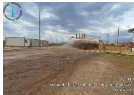
Figura 39 - Aspersão de água nos acessos. Fonte: Vale, dezembro de 2025.
