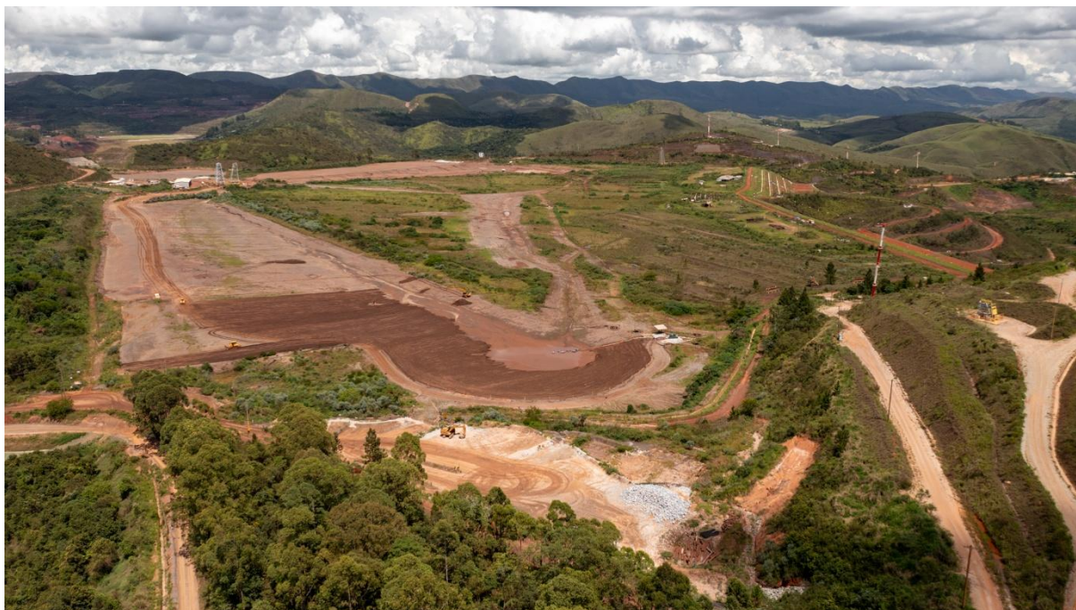
Figura 8 - Sistema de bombeamento operacional Sump 2 (janeiro/25).
