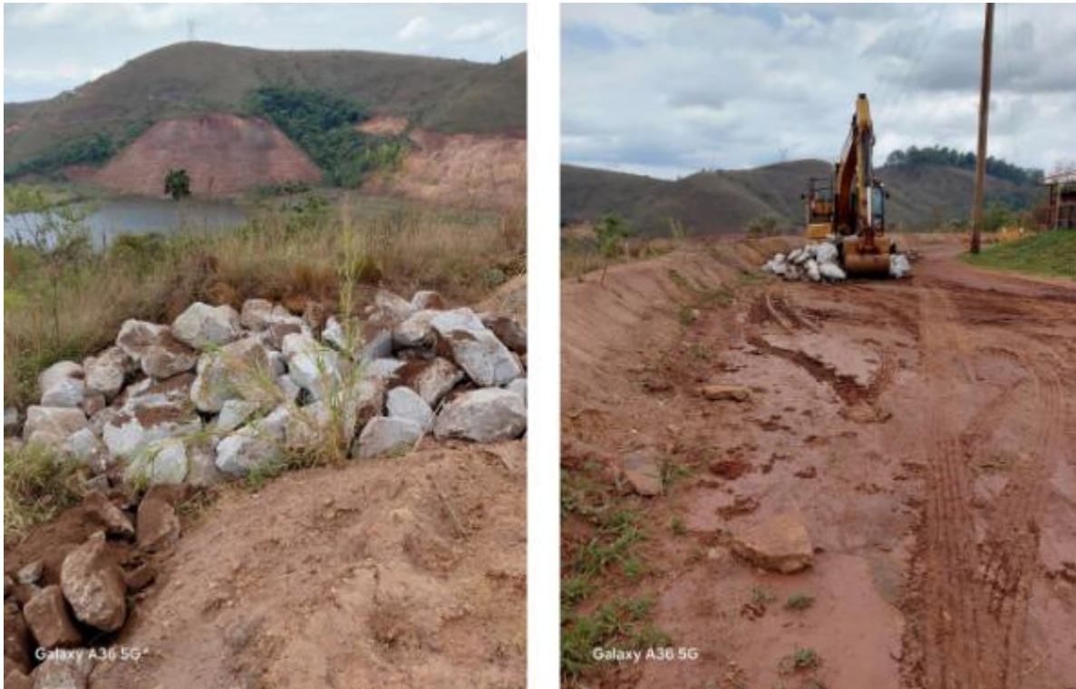
Figura 7 - Atendimento recomendação F2-0336, canteiro administrativo Forquilha II
