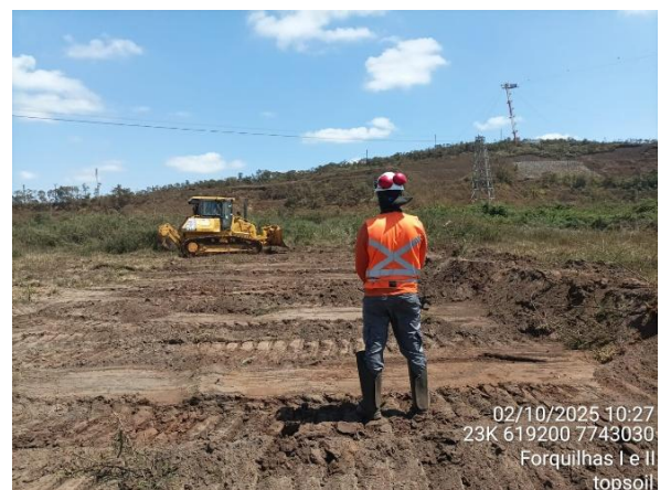
Figura 30 – Acompanhamento da atividade de remoção de topsoil na barragem Forquilha I e II. Fonte: Vale, 2025.
