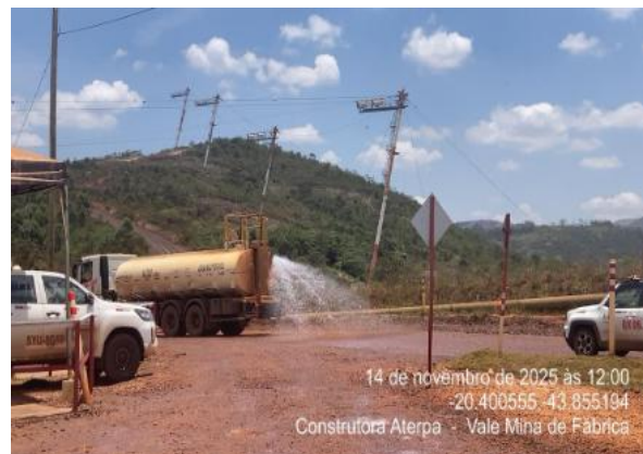
Figura 37 - Aspersão de água nos acessos de obra. Fonte: Vale, novembro de 2025.
