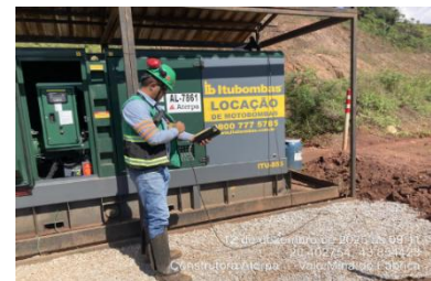
Figura 46 - Teste de opacidade em uma motobomba. Fonte: Vale, dezembro de 2025.
