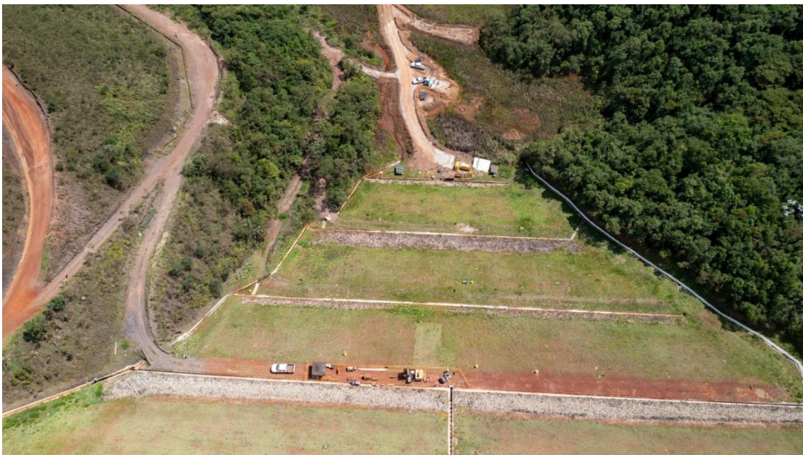
Figura 18 - Execução dos poços de rebaixamento e campanha de investigação (janeiro/26).
