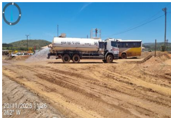
Figura 57 - Umectação de acessos. Fonte: Vale, novembro de 2025.
