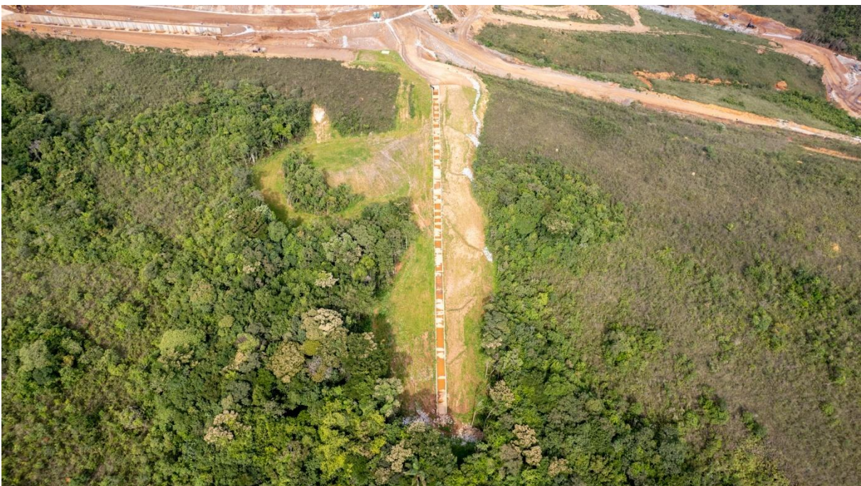
Figura 52 - Aplicação de MVP na DAD/canal de desvio, em 15/01/2026. Fonte: Vale, 2025.
