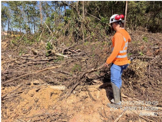
Figura 41 - Vistoria prévia na área de remoção de topsoil na barragem Forquilha III – Mina de Fábrica. Fonte: Concremat, 2025.
