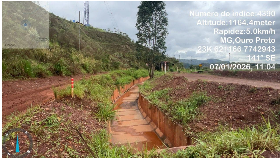
Figura 30 - Estado de conservação dos canais de cintura (janeiro/2026).
