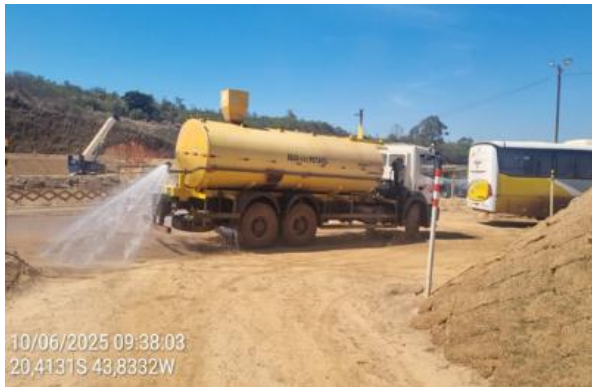
Figura 55 - Caminhão pipa realizando aspersão de vias não pavimentadas. Fonte: Vale, outubro de 2025.
