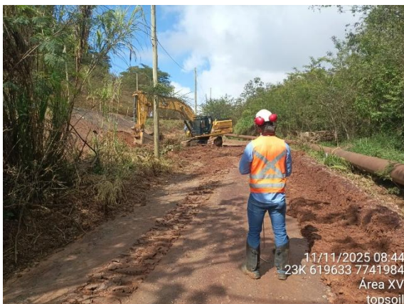
Figura 43 - Acompanhamento da atividade de remoção de topsoil em Forquilha III – Mina de Fábrica. Fonte: Concremat, 2025.
