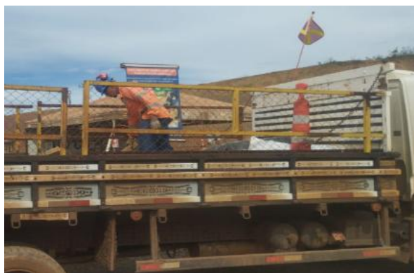
Figura 112 – Limpeza e recolhimento dos resíduos nas frentes de serviços. Fonte: Vale, dezembro de 2025.
