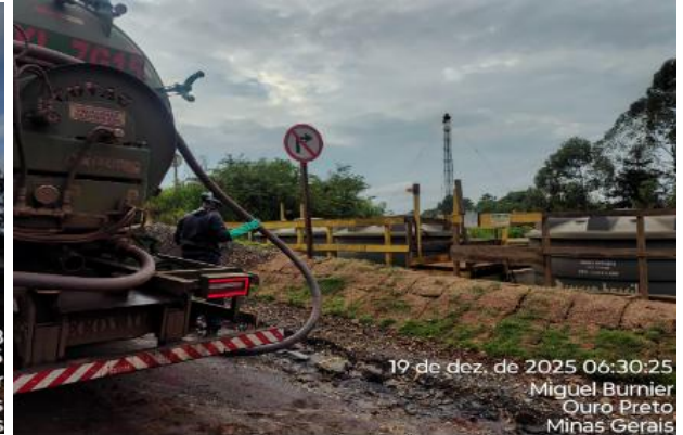
Figura 102 - Recolhimento dos efluentes armazenados nos tanques sépticos. Fonte: Vale, dezembro de 2025.
