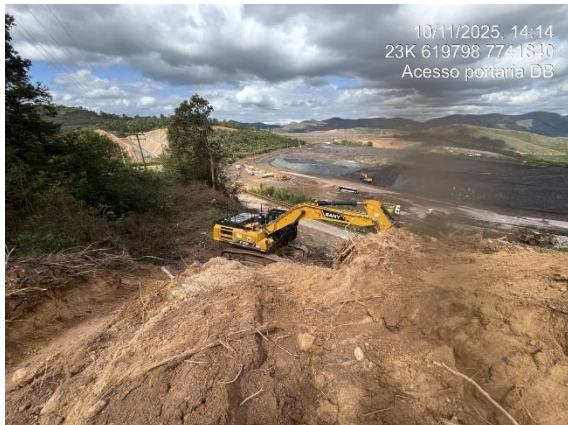
Figura 47 - Atividade de remoção de topsoil na Área XV. Fonte: Concremat, 2025.
