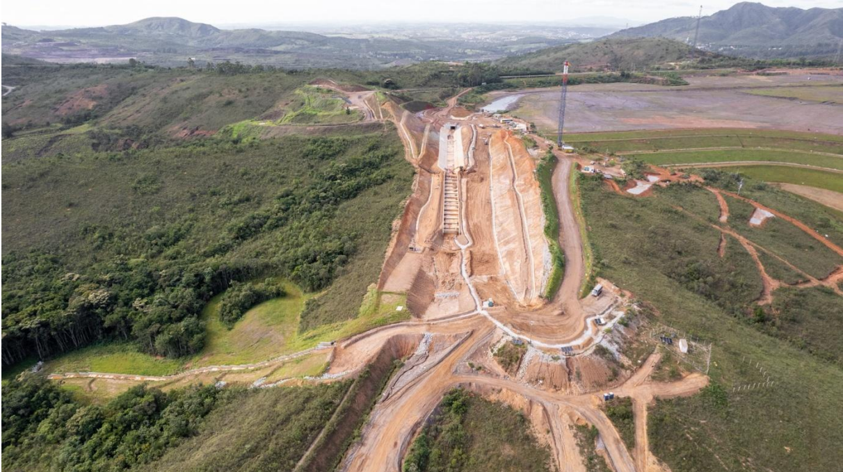
Figura 51 - Aplicação de MVP na DAD/canal de desvio e no acesso da ombreira direita, em 15/01/2026. Fonte: Vale, 2025.
