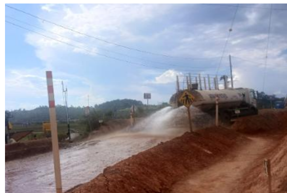
Figura 60 - Umectação das vias não pavimentadas em Forquilha III. Fonte: Vale, dezembro de 2025.
