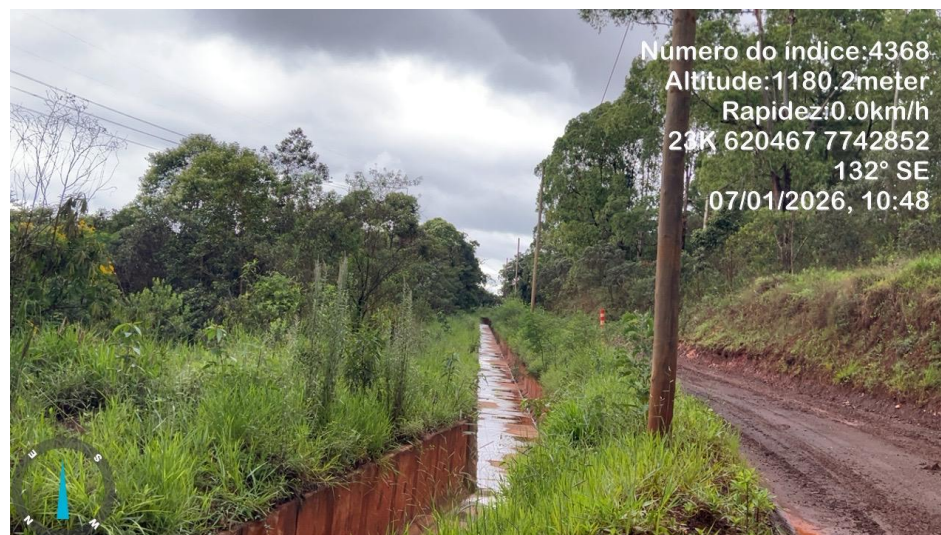
Figura 25 - Estado de conservação dos canais de cintura (janeiro/2026).
