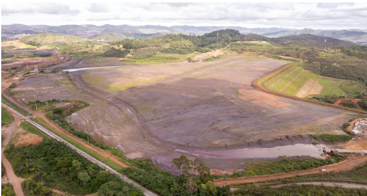
Figura 6 - Manutenção de canais, sumps e raspagem do reservatório – janeiro/25.
