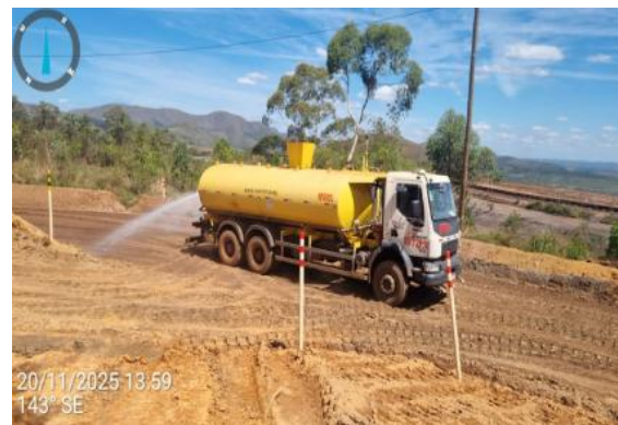
Figura 58 - Caminhão pipa realizando aspersão das vias não pavimentadas. Fonte: Vale, novembro de 2025.
