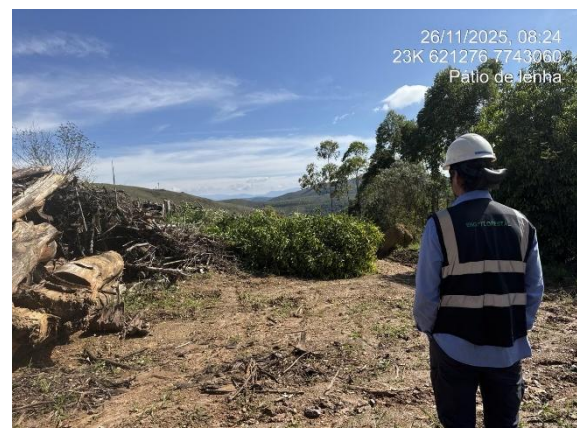
Figura 50 - Acompanhamento da atividade de supressão vegetal no Pátio de Lenha. Fonte: Concremat, 2025.
