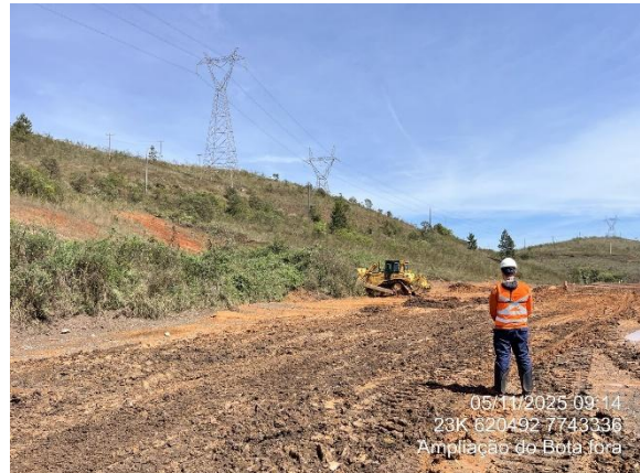
Figura 42 - Acompanhamento da atividade de remoção de topsoil para ampliação do bota fora em Forquilha III – Mina de Fábrica. Fonte: Concremat, 2025.
