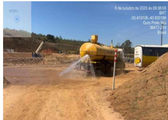
Figura 56 - Aspersão nos acessos de Forquilha III. Fonte: Vale, outubro de 2025.
