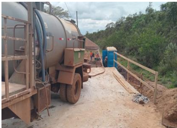
Figura 99 - Higienização de banheiros químicos nas frentes de serviços. Fonte: Vale, novembro de 2025.
