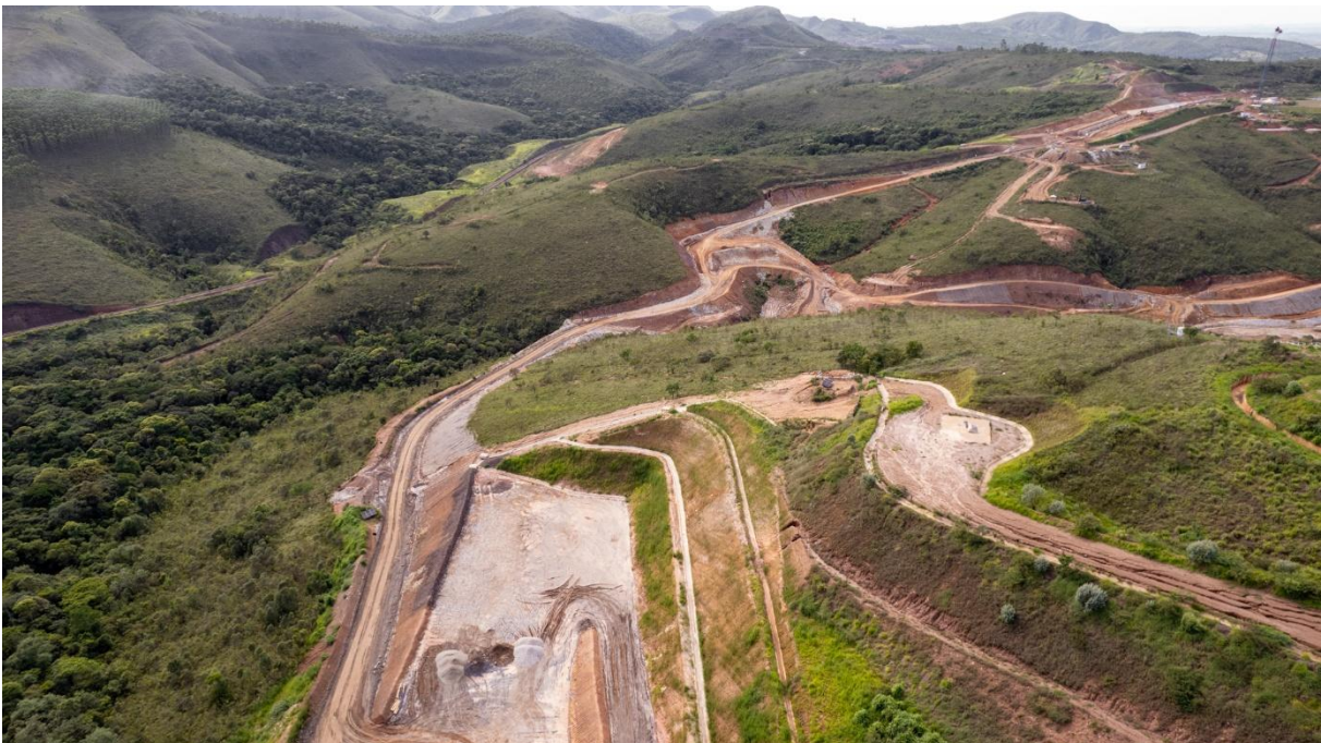
Figura 18 - Visão geral –acessos construtivos ombreira esquerda. (janeiro/2026).
