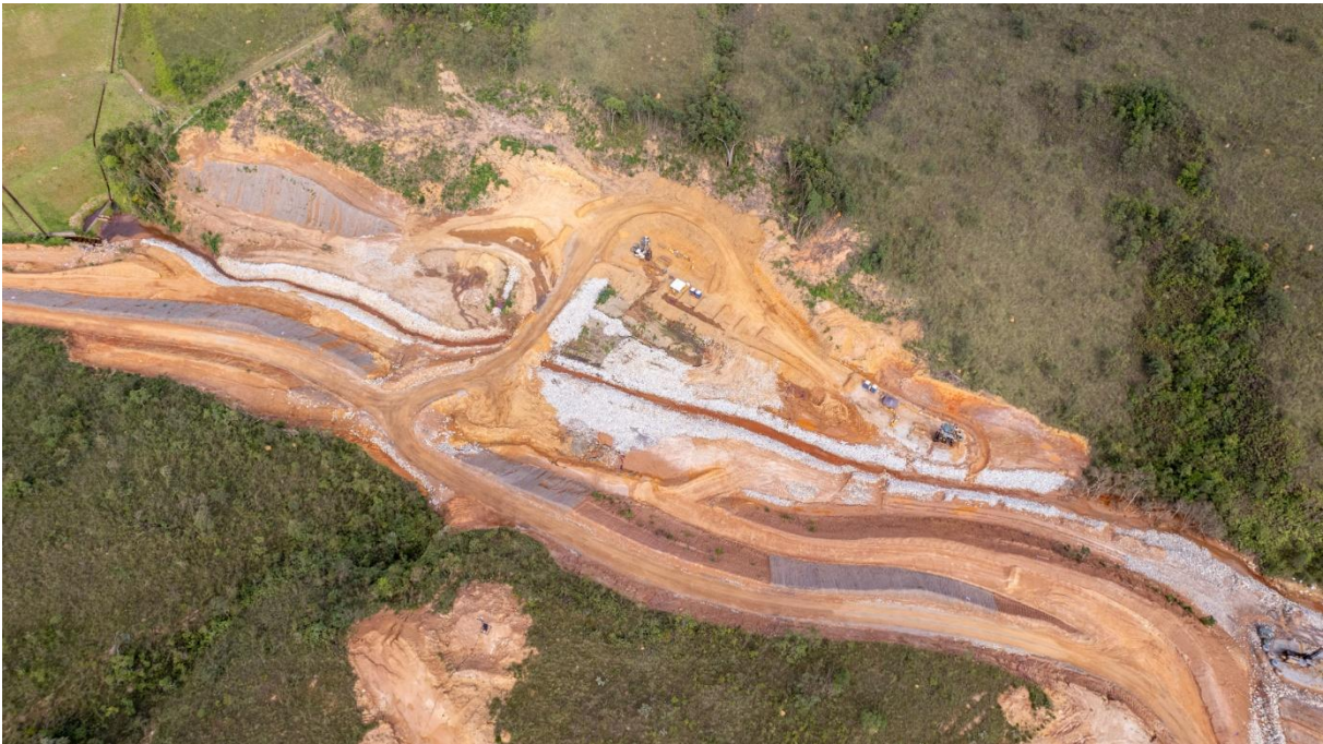
Figura 22 - Condição de fluxo de água após adequação do canal em enrocamento e passagens sob acesso provisório (janeiro/26) – recomendação F3-0565.
