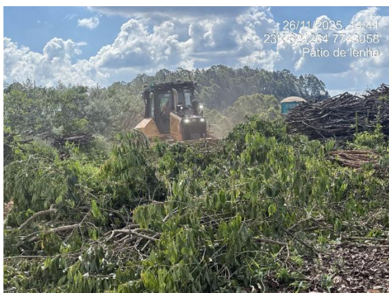
Figura 49 - Atividade de remoção de topsoil no Pátio de Lenha. Fonte: Concremat, 2025.
