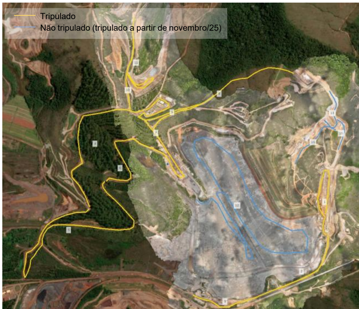
Figura 54 - Rotograma do caminhão-pipa tripulado e não tripulado para aspersão dos acessos às obras da barragem Forquilha III (novembro de 2025 – vigente em janeiro de 2026).
