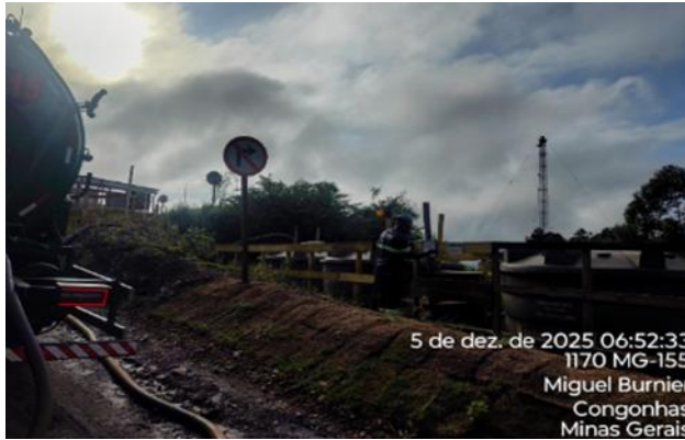
Figura 101 – Recolhimento dos efluentes armazenados nos tanques sépticos. Fonte: Vale, dezembro de 2025.
