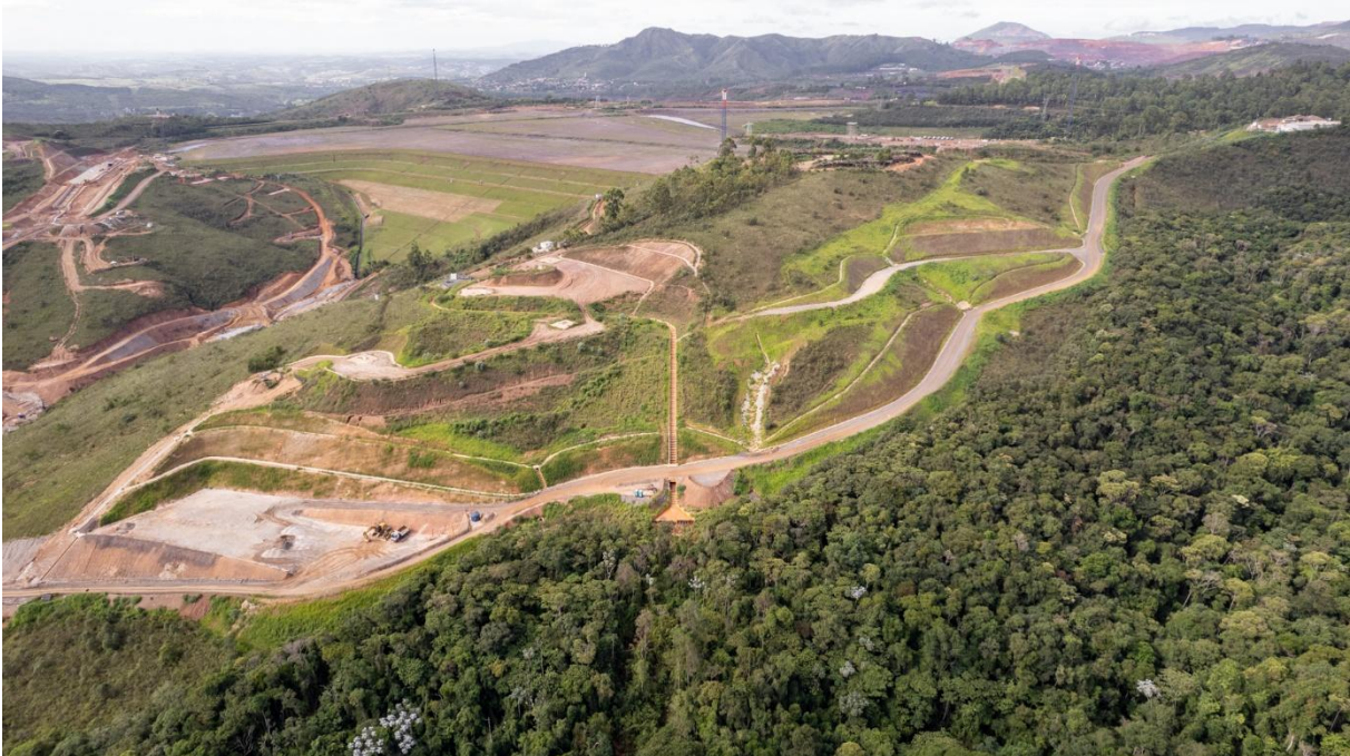
Figura 17 - Visão geral – obras dos acessos construtivos ombreira esquerda. (janeiro/2026).
