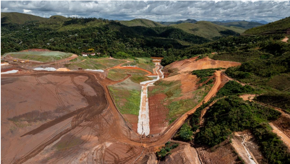
Figura 8 - Vista geral da obra com canal de restituição concluído –janeiro/2026.
