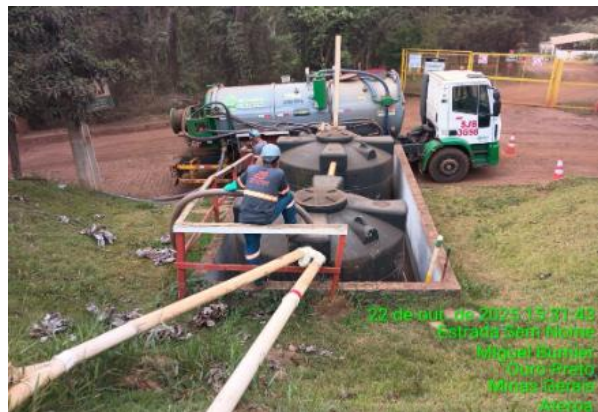
Figura 74 – Sucção de efluentes dos tanques localizados no canteiro de obra. Fonte: Vale, outubro de 2025.
