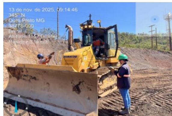
Figura 43 – Teste de opacidade realizado em equipamento. Fonte: Vale, novembro de 2025.
