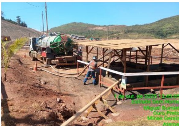
Figura 73 – Sucção de efluentes dos tanques localizados no canteiro de obras. Fonte: Vale, outubro de 2025.
