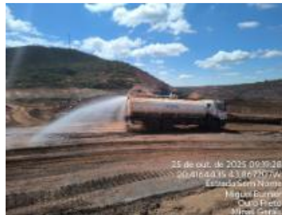
Figura 35 - Caminhão pipa realizando aspersão das vias. Fonte: Vale, outubro de 2025.
