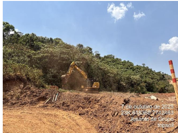
Figura 24 - Atividades de remoção de topsoil na região a jusante da antiga barragem Grupo - Mina de Fábrica. Fonte: Concremat, 2025.
