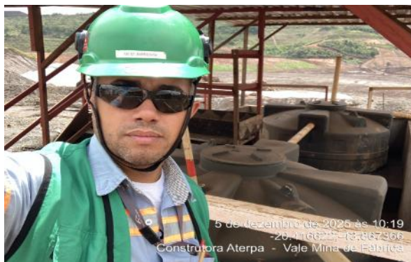
Figura 78 - Inspeção nos tanques de efluentes do canteiro avançado de Grupo. Fonte: Vale, dezembro de 2025.
