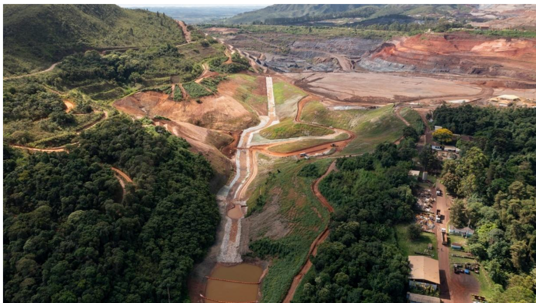
Figura 94 - Execução do canal de restituição/descharacterização, bacia de dissipação e sump de jusante. Fonte: Vale, 2025
