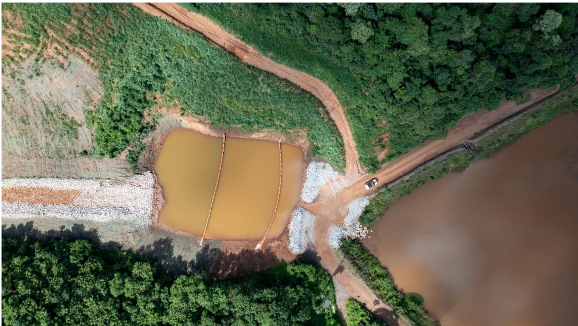
Figura 11 – Sump ambiental – janeiro/2026.
