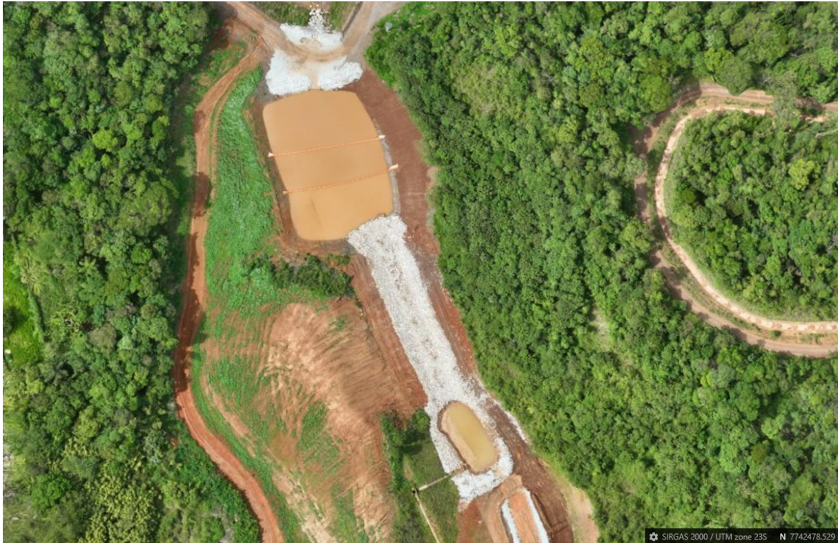
Figura 95: Reconformação do trecho de acordo com a geometria do projeto e a aplicação de enrocamento D20 = 300 mm, entre a bacia de dissipação e o sump (03/12/2025).
