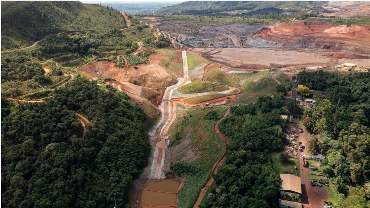
Figura 101 - Revegetação das margens esquerda e direita de Grupo, com aplicação de MVP (13/01/2026).
