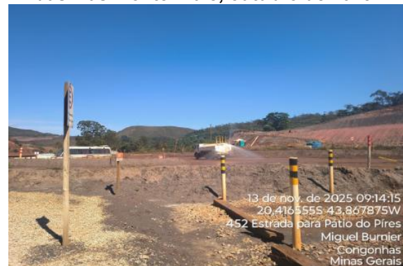
Figura 37 - Aspersão de água nos acessos de obra. Fonte: Vale, novembro de 2025.
