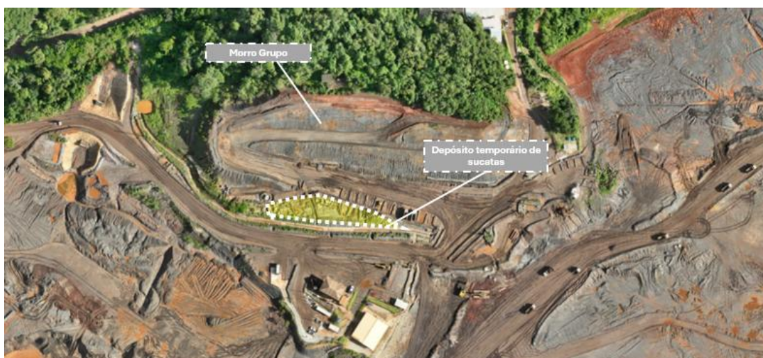
Figura 5 - Área de estocagem temporária de sucatas removidas da estrutura para posterior destinação ao CMD – condição permanece até o momento.
