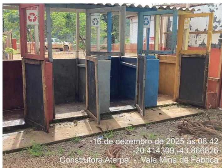
Figura 89 – Processo de desmobilização do DIR do canteiro de Grupo. Fonte: Vale, dezembro de 2025.
