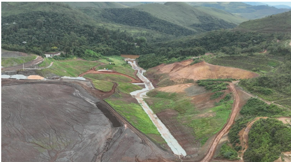
Figura 2 – Canal de restituição - Talvegue de Grupo
