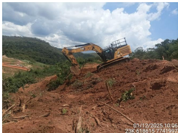
Figura 26 - Atividades de remoção de topsoil na Ombreira Direita da antiga barragem Grupo - Mina de Fábrica. Fonte: Concremat, 2025.
