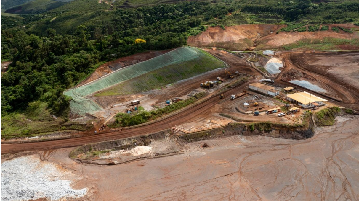
Figura 103 - Revegetação do morro de Grupo, com aplicação de MVP (13/01/2026). Fonte: Vale, 2025.
