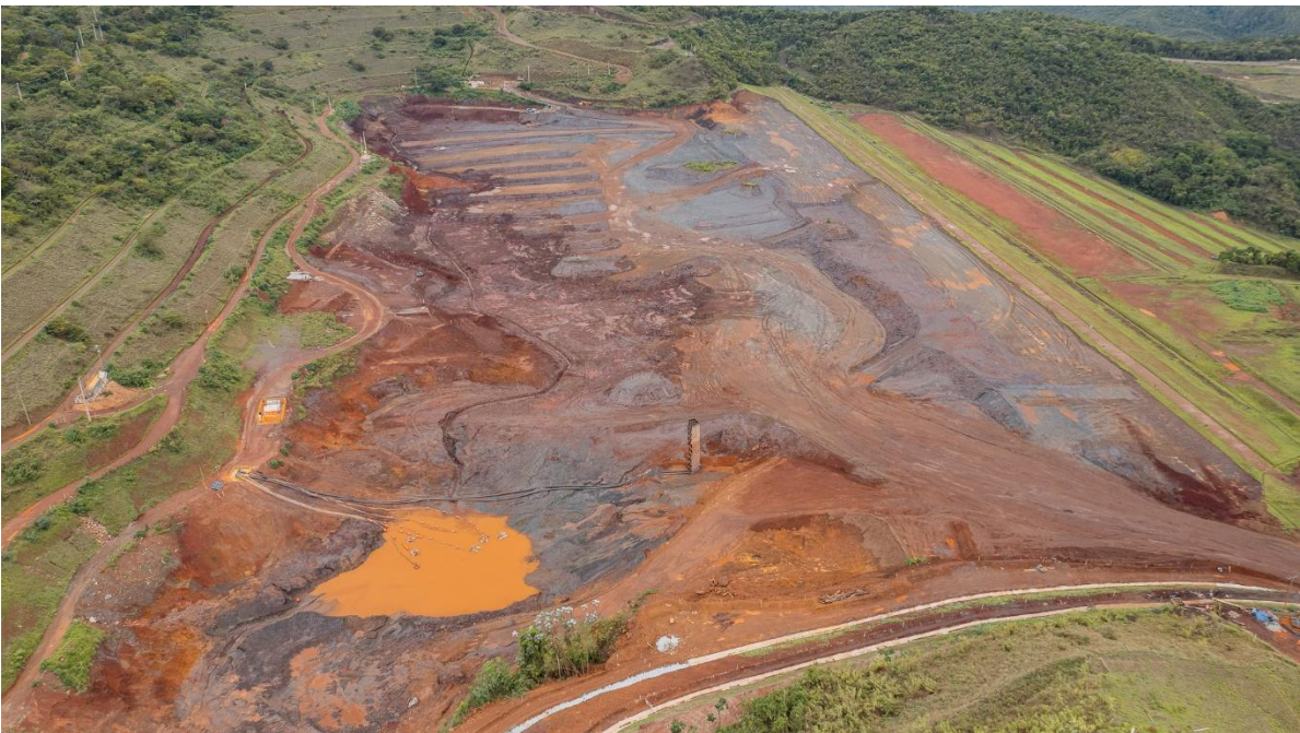
Figura 23 - Vista ombreira direita da BSS – Remoção de rejeitos no reservatório e barramento (dezembro/2025).
