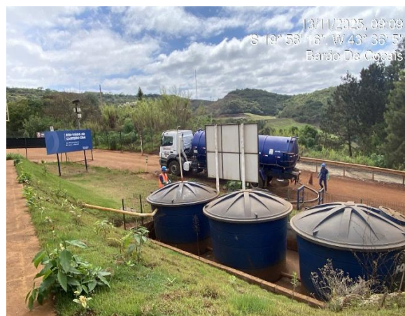
Figura 53 - Sucção da fossa – canteiro de obra.
