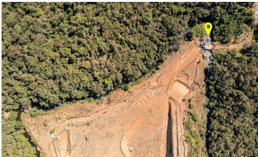
Figura 64 - GSO Remanso. Fonte: Vale, 2024.
