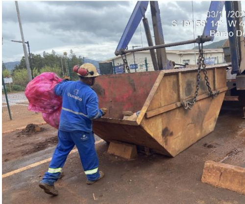
Figura 55 - Recolhimento de resíduos Fonte: Vale, 2025.
