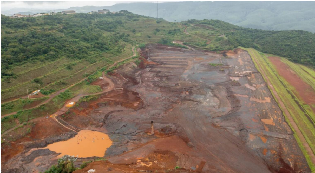
Figura 25 - Aspecto geral do reservatório da BSS evidenciado os canais principal e periférico no reservatório. Fonte: Vale, 2026.
