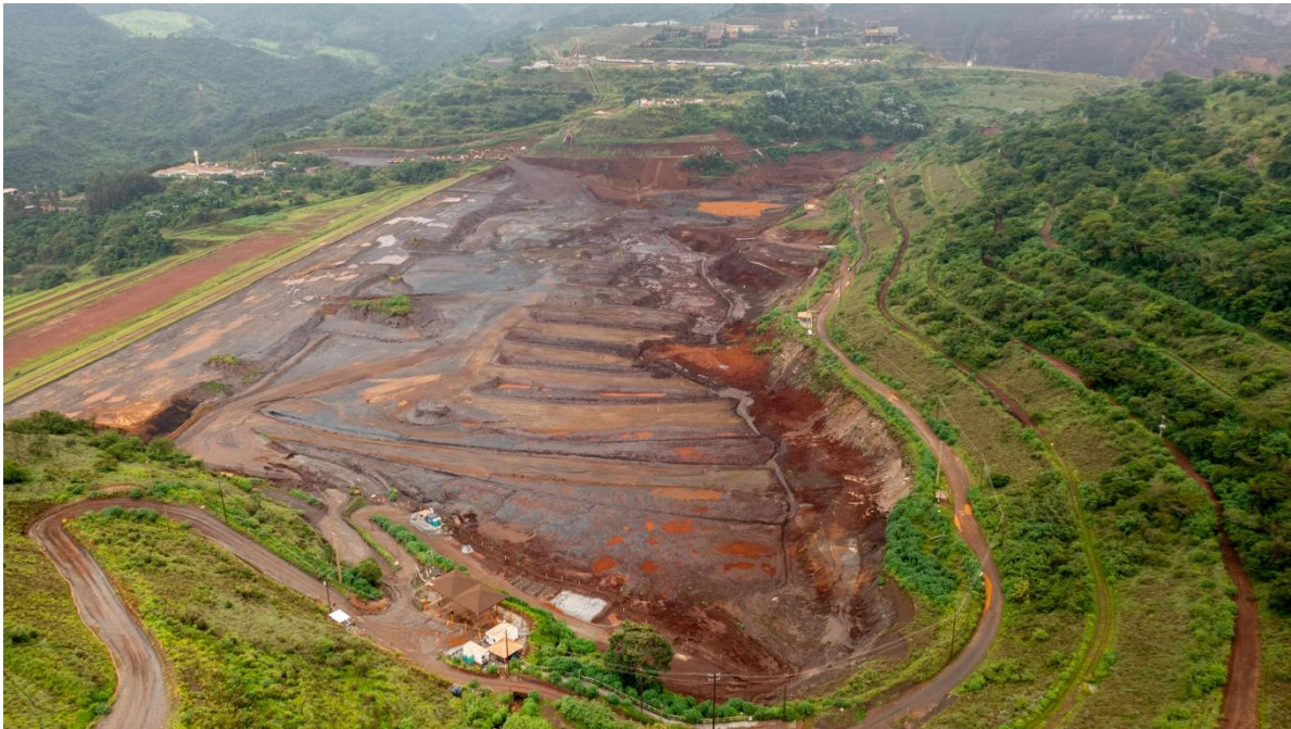
Figura 22 - Vista ombreira esquerda da BSS (dezembro/2025), escavação do reservatório e barramento.
