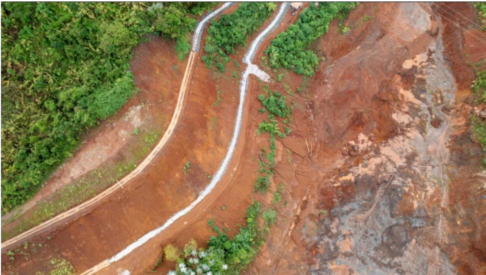
Figura 26 – Finalização da implantação de drenagem – Ombreira Direita. Fonte: Vale, 2025.
