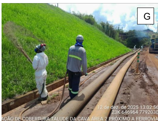
Figura 34 – (A, B, C, D, E, F, G) Aplicação de RAD. Fonte: Vale, 2025.
