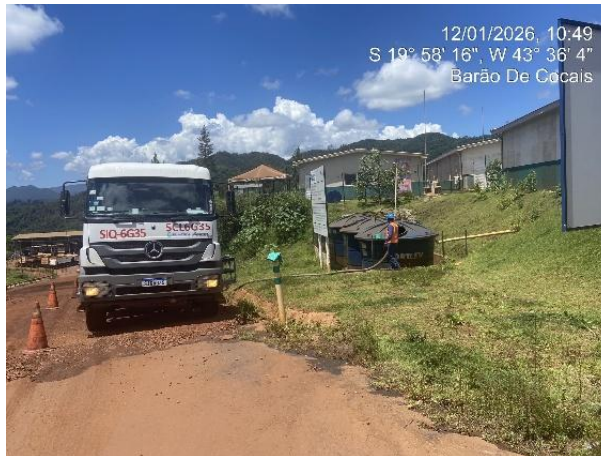
Figura 54 - Sucção da fossa – canteiro de obra. Fonte: Vale, 2026.
