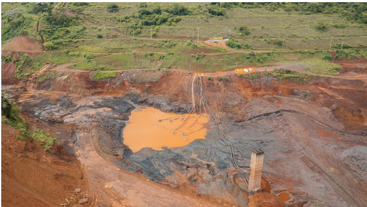
Figura 5 - Sump da BSS (Fase 2) – Dez/25
