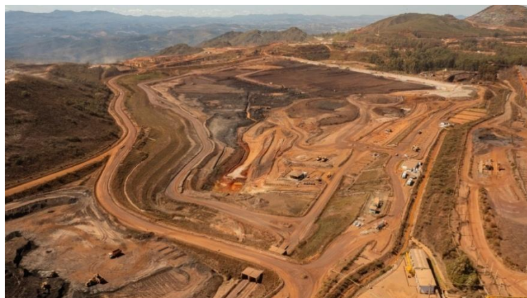
Figura 46 - Vista da Barragem Vargem Grande, após processo de revegetação bem estabelecido da ombreira esquerda da barragem – período de seca. (Fonte: Vale, 25 de agosto de 2025).
