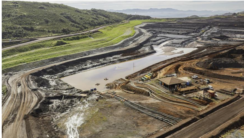
Figura 32 - Vista da Barragem Vargem Grande, após processo de revegetação bem estabelecido da ombreira esquerda da barragem. (Fonte: Vale, 01 de abril de 2024).
