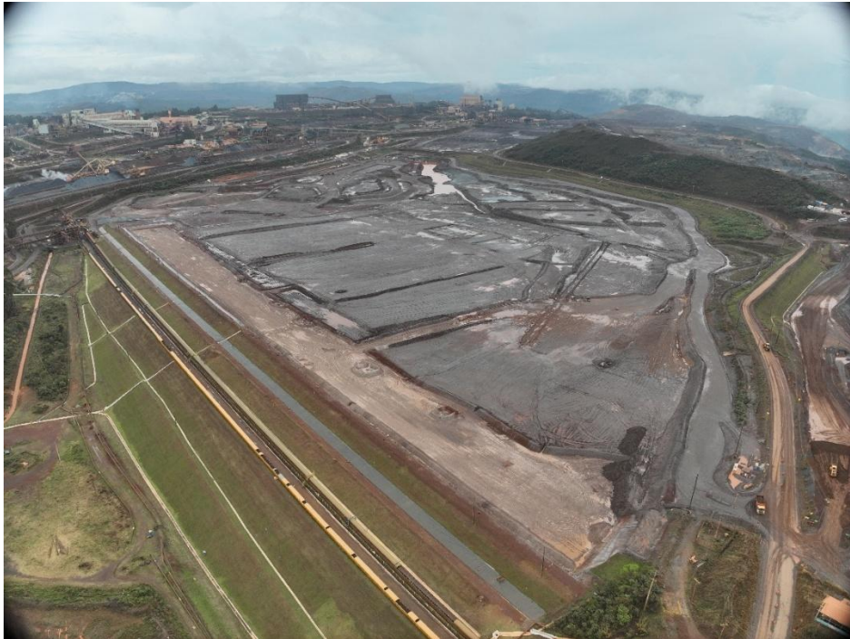
Figura 10 – Remoção do 3 alçamento da barragem.
