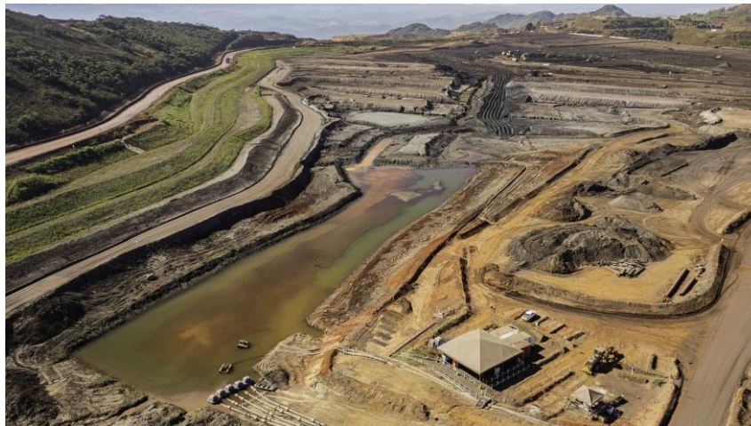
Figura 33 - Vista da Barragem Vargem Grande, após processo de revegetação bem estabelecido da ombreira esquerda da barragem – período de seca. (Fonte: Vale, 06 de junho de 2024).
