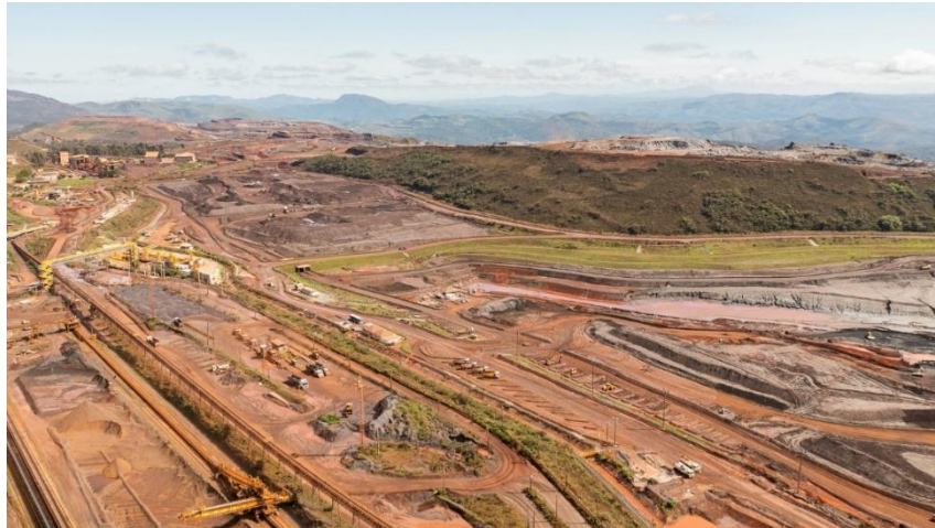
Figura 38 - Vista da Barragem Vargem Grande, após processo de revegetação bem estabelecido da ombreira esquerda da barragem – período chuvoso. (Fonte: Vale, 27 de novembro de 2024).
