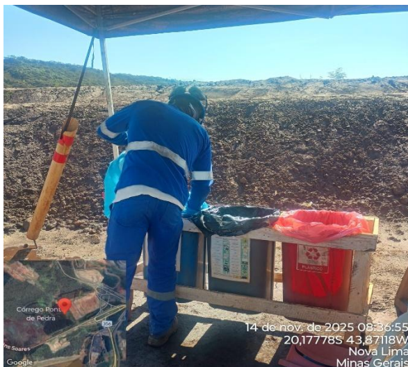
Figura 94 – Recolhimento dos resíduos conforme coleta seletiva nas frentes de serviço. (Fonte: Vale, novembro de 2025)
