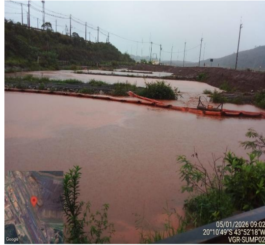
Figura 101 – Vista de cortina de turbidez e cordão para contenção de óleo instalado no SUMP CC-02 (Fonte: Vale, janeiro de 2026)
