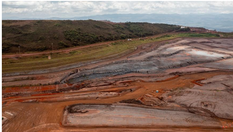
Figura 48 - Vista da Barragem Vargem Grande, após processo de revegetação bem estabelecido da ombreira esquerda da barragem – período chuvoso. (Fonte: Vale, 29 de novembro de 2025).
