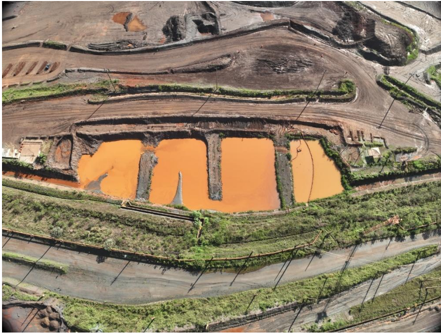
Figura 99 - Imagem aérea do SUMP-CC02. (Fonte: Vale, dezembro de 2025)
