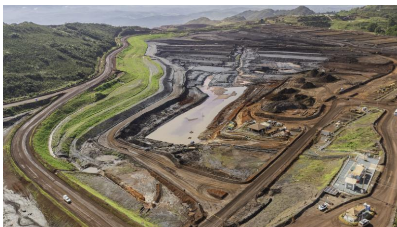
Figura 31 - Vista da Barragem Vargem Grande, após processo de revegetação bem estabelecido da ombreira esquerda da barragem. (Fonte: Vale, 01 de abril de 2024).
