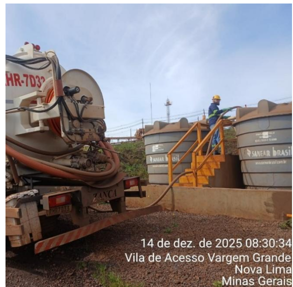
Figura 90 - Sucção do tanque séptico no canteiro avançado. (Fonte: Vale, dezembro de 2025).
