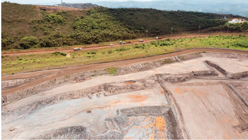
Figura 50 - Vista da Barragem Vargem Grande, após processo de revegetação bem estabelecido da ombreira esquerda da barragem – período chuvoso. (Fonte: Vale, 29 de novembro de 2025).
