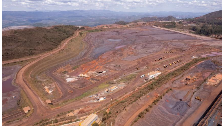
Figura 47 - Vista da Barragem Vargem Grande, após processo de revegetação bem estabelecido da ombreira esquerda da barragem – período chuvoso. (Fonte: Vale, 05 de novembro de 2025).
