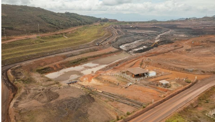
Figura 44 - Vista da Barragem Vargem Grande, após processo de revegetação bem estabelecido da ombreira esquerda da barragem – período de seca. (Fonte: Vale, 30 de maio de 2025).
