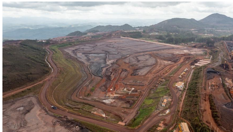
Figura 49 - Vista da Barragem Vargem Grande, após processo de revegetação bem estabelecido da ombreira esquerda da barragem – período chuvoso. (Fonte: Vale, 29 de novembro de 2025).
