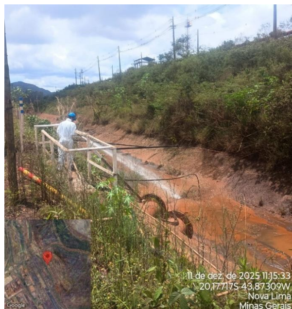
Figura 29 – Limpeza da área do dosador de coagulante (Fonte: Vale, dezembro de 2025).
