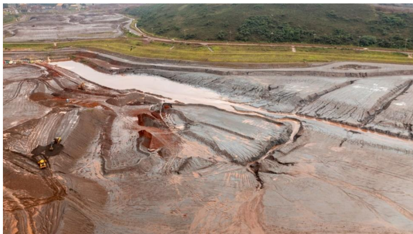
Figura 40 - Vista da Barragem Vargem Grande, após processo de revegetação bem estabelecido da ombreira esquerda da barragem – período chuvoso. (Fonte: Vale, janeiro de 2025).
