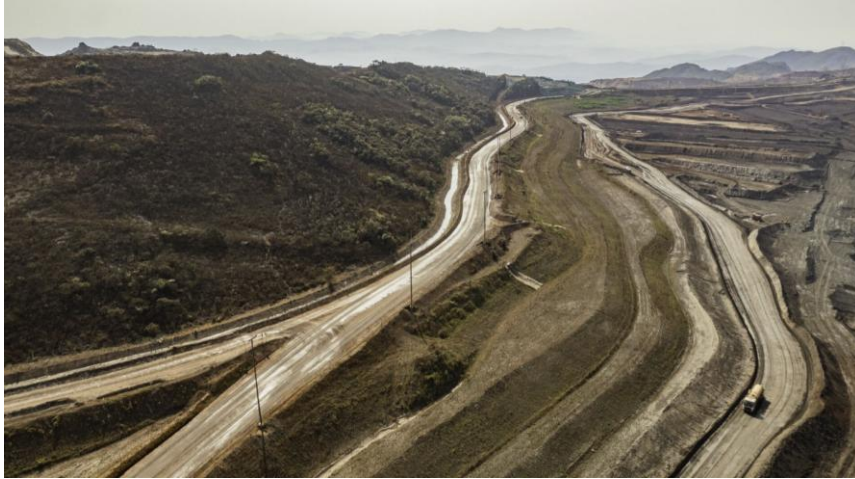
Figura 35 - Vista da Barragem Vargem Grande, após processo de revegetação bem estabelecido da ombreira esquerda da barragem – período de seca. (Fonte: Vale, 27 de setembro de 2024).
