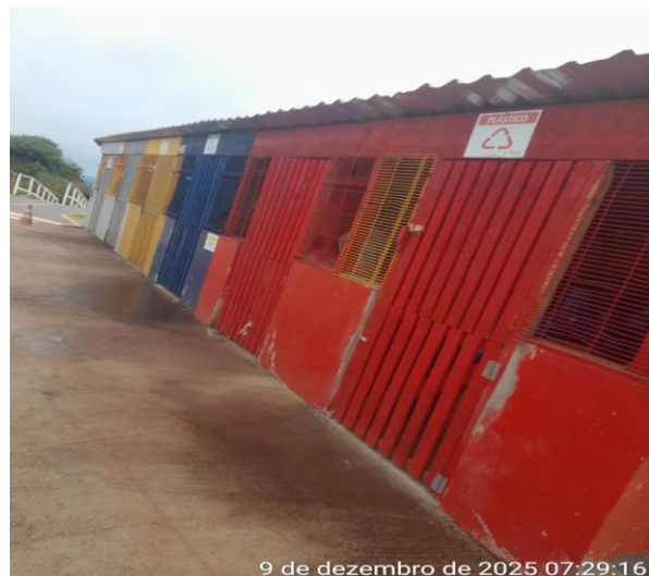
Figura 95 – Inspeção diária no DIR. (Fonte: Vale, dezembro de 2025).
