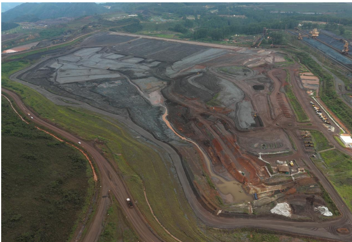
Figura 16 - Vista do Sump 1 com drenagem do reservatório de jusante para montante (19/01/2026).
