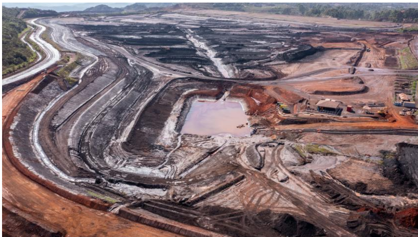
Figura 30 - Vista da Barragem Vargem Grande, com foco na ombreira esquerda, durante o período de aplicação de MVP (Fonte: Vale, 01 de dezembro de 2023).
