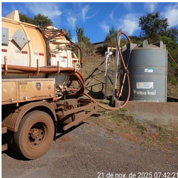
Figura 89 - Sucção do tanque séptico no canteiro definitivo. (Fonte: Vale, novembro de 2025).
