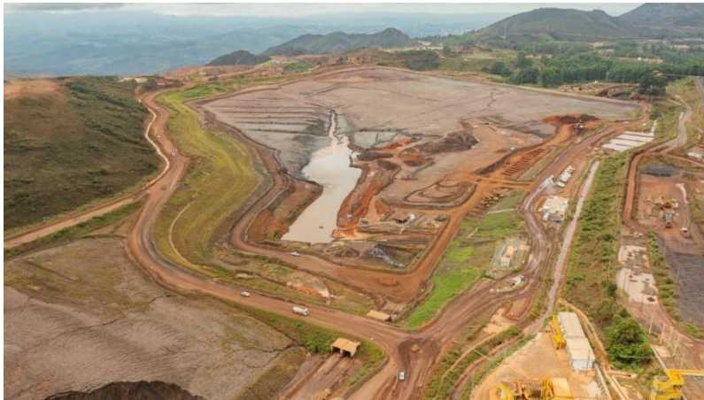
Figura 42- Vista da Barragem Vargem Grande, após processo de revegetação bem estabelecido da ombreira esquerda da barragem – período chuvoso. (Fonte: Vale, março de 2025).
