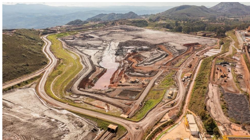
Figura 37 - Vista da Barragem Vargem Grande, após processo de revegetação bem estabelecido da ombreira esquerda da barragem – período chuvoso. (Fonte: Vale, 27 de novembro de 2024).
