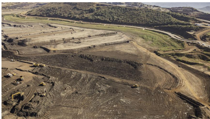
Figura 34 - Vista da Barragem Vargem Grande, após processo de revegetação bem estabelecido da ombreira esquerda da barragem – período de seca. (Fonte: Vale, 06 de junho de 2024).
