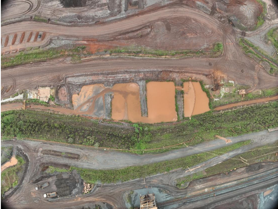
Figura 23 - Visão da limpeza do SUMP 02 para contenção de sedimentos (19/01/2026).
