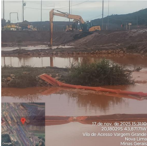
Figura 100 – Manutenção do SUMP com vista da cortina de turbidez instalada no SUMP CC-02 (Fonte: Vale, novembro de 2025)
