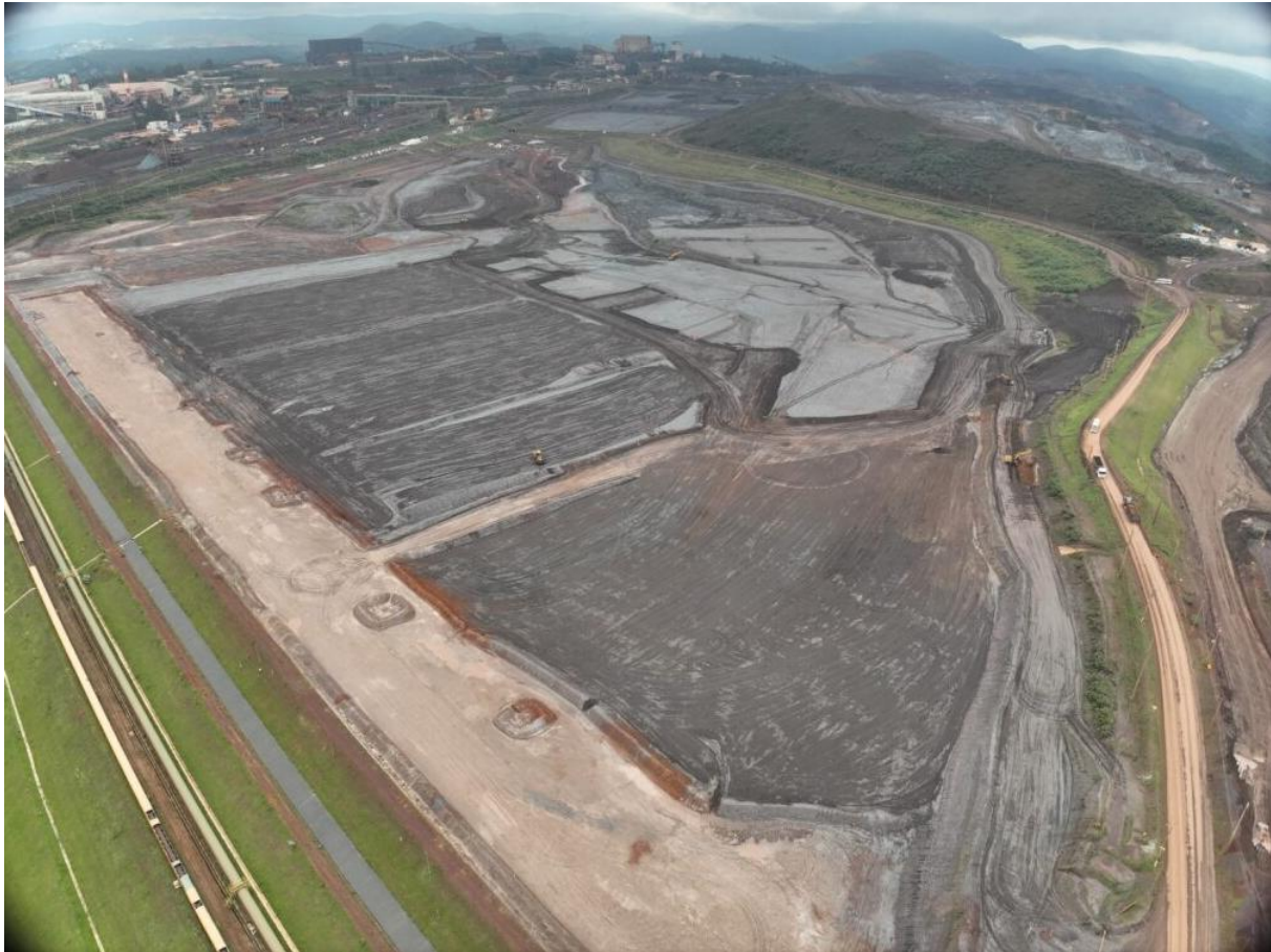
Figura 17 – Vista geral da Barragem Vargem Grande.
