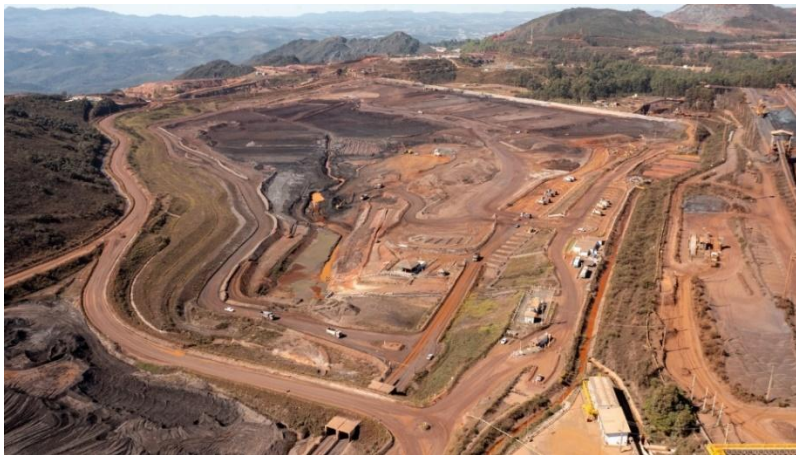
Figura 45 - Vista da Barragem Vargem Grande, após processo de revegetação bem estabelecido da ombreira esquerda da barragem – período de seca. (Fonte: Vale, 27 de junho de 2025).
