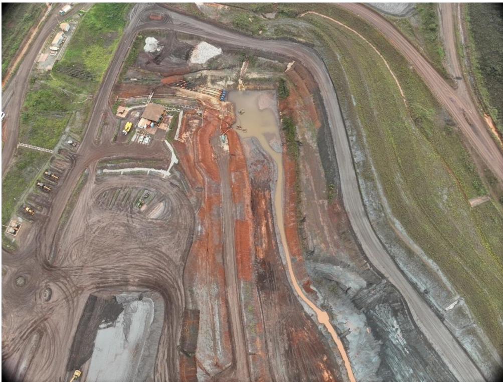
Figura 22 - Vista do reservatório com os canais de drenagem direcionando o efluente para região a montante, junto ao SUMP 1, bem como início das atividades de descaracterização conforme projeto (19/01/2026).
