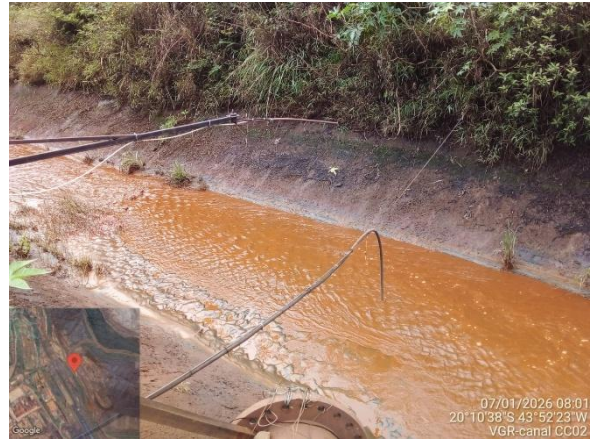
Figura 103 – Vista do sistema automatizado de dosagem de flocculante. (Fonte: Vale, janeiro de 2026)
