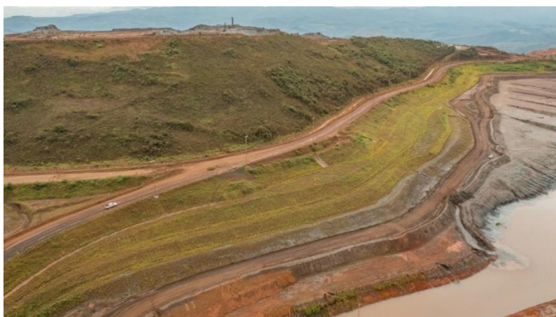
Figura 43 - Vista da Barragem Vargem Grande, após processo de revegetação bem estabelecido da ombreira esquerda da barragem – período chuvoso. (Fonte: Vale, março de 2025).
