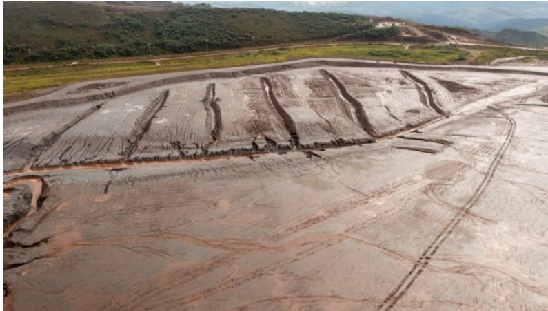
Figura 41 - Vista da Barragem Vargem Grande, após processo de revegetação bem estabelecido da ombreira esquerda da barragem – período chuvoso. (Fonte: Vale, janeiro de 2025).
