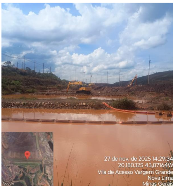
Figura 28 - Realização de limpeza no SUMP CC02 (Fonte: Vale, novembro de 2025).
