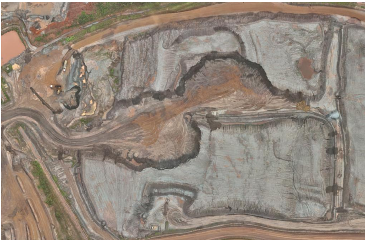
Figura 8 – Remoção de rejeito da barragem.
