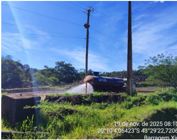
Figura 46 - Umectação de vias no acesso de entrada da portaria. Fonte: Vale, 2025.
