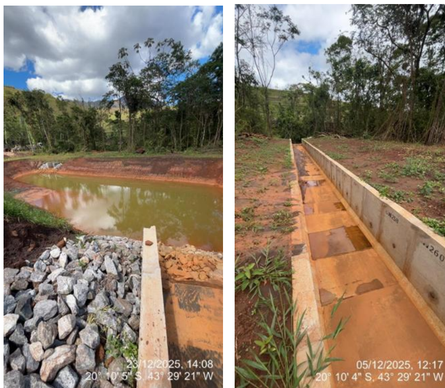
Figura 40 – Sump 2 e canaleta extravasora. Fonte: Vale, 2026.
