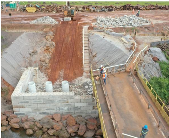
Figura 37 – Fundação da Ponte
