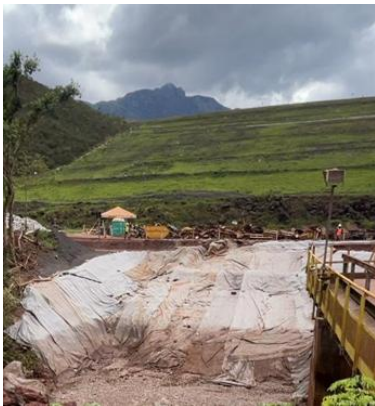
Figura 45 Proteção com manta bidin na área de escavação da ponte. Fonte: Vale, 2025.
