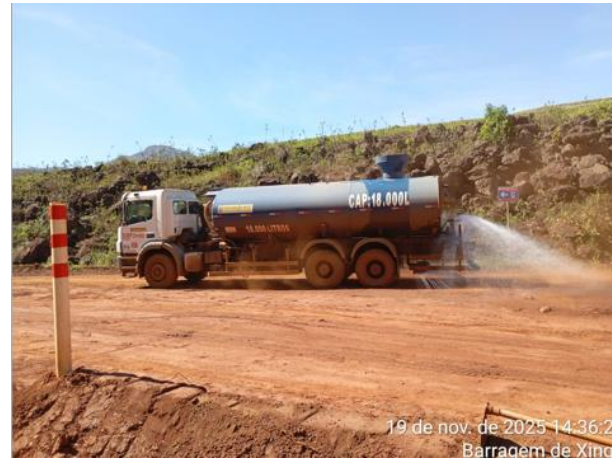
Figura 47 - Umectação de vias próximo ao Dique 02. Fonte: Vale, 2025.
