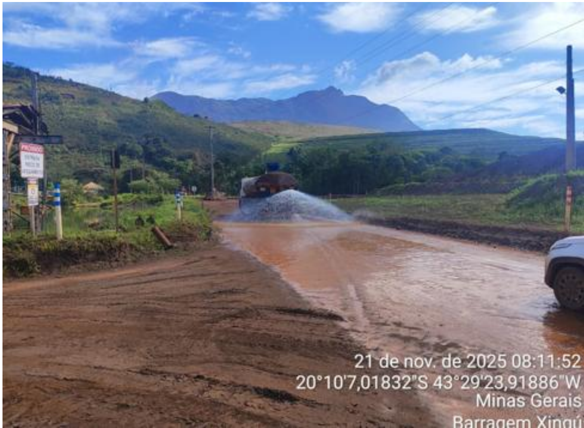
Figura 48 - Umectação de vias próximo as baias. Fonte: Vale, 2025.
