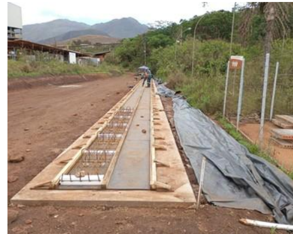
Figura 32 - Pré laje da ponte
