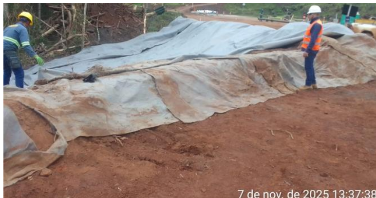
Figura 45 Proteção com manta bidin na área de escavação da ponte. Fonte: Vale, 2025.
