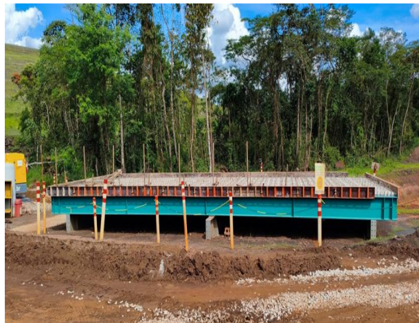
Figura 38 – Pré montagem da ponte
