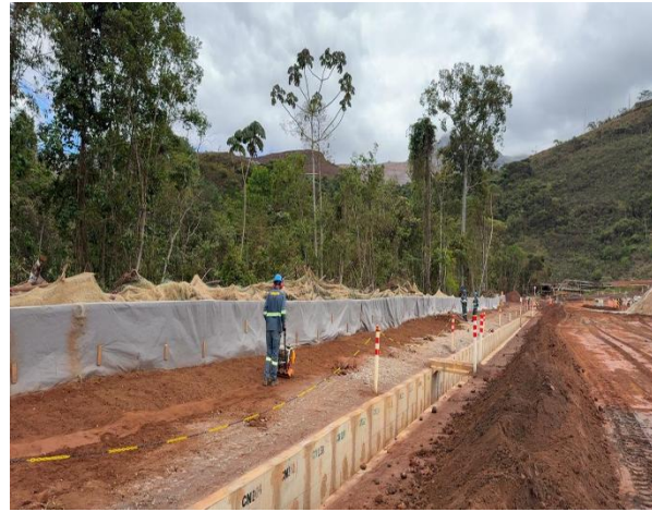
Figura 36 – Barreira de sedimentos
